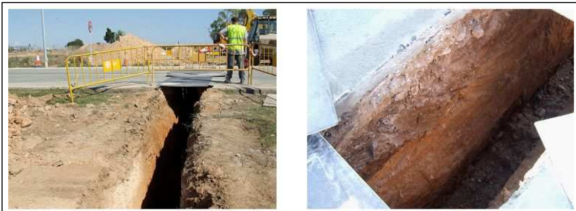
Izquierda: cruce de carretera secundaria. Derecha: V-224. Corte estratigráfico resultante.
