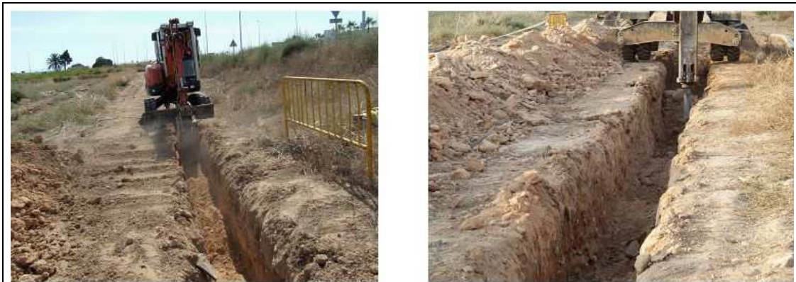
Izqda.: apertura de zanja entre los vértices de proyecto V-211 y V-212. Dcha.: veta de roca.
