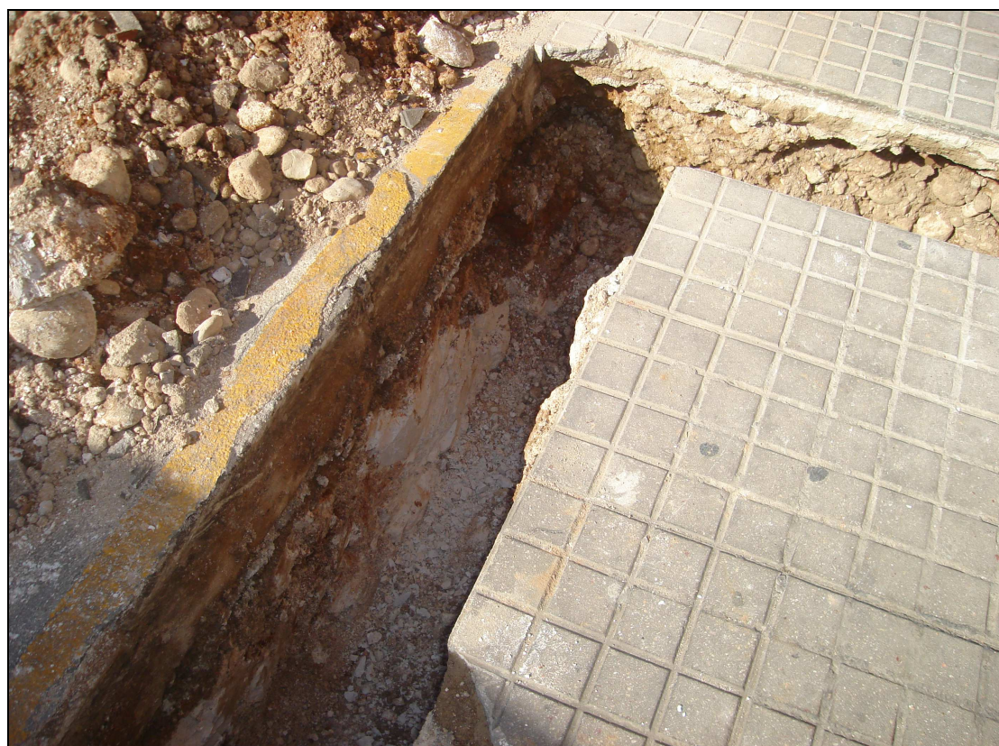
Detall de la rasa excavada amb el taulell hidràulic de la vorera.
