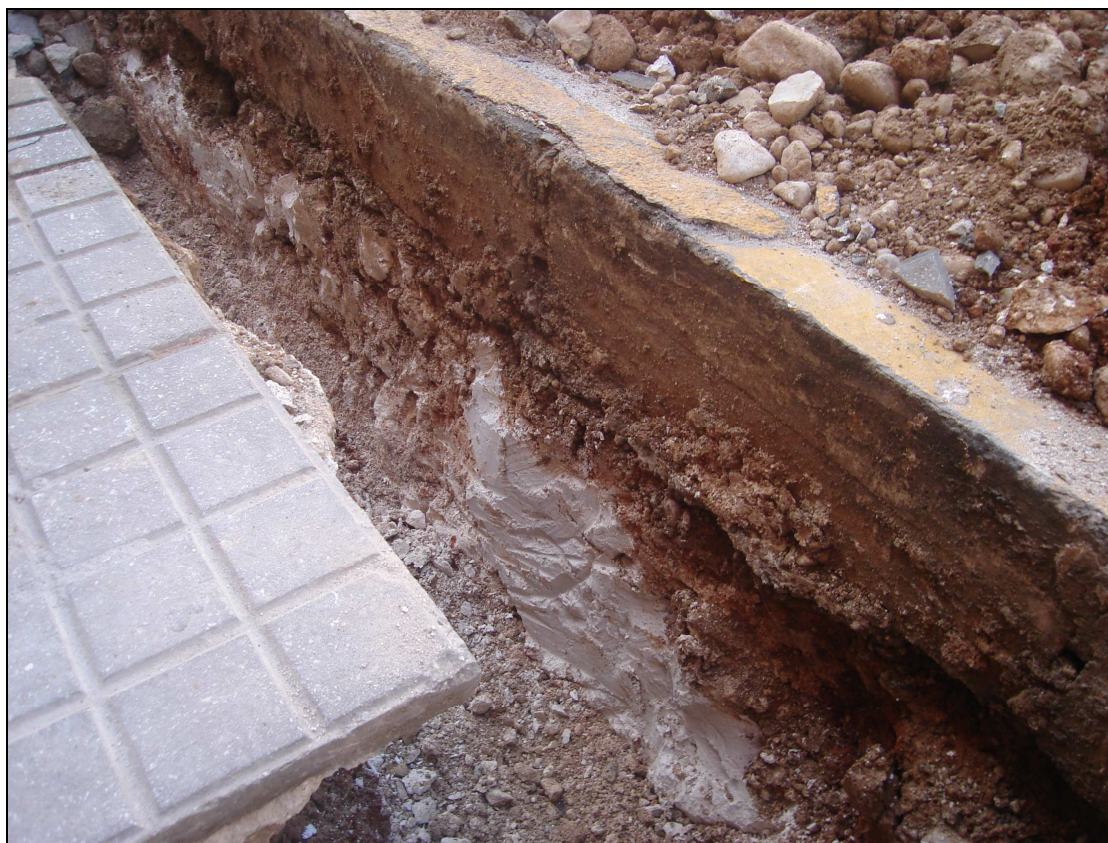
Vista parcial de la rasa excavada en la vorera dreta (est) de l'avinguda Ronda de les Muralles.
