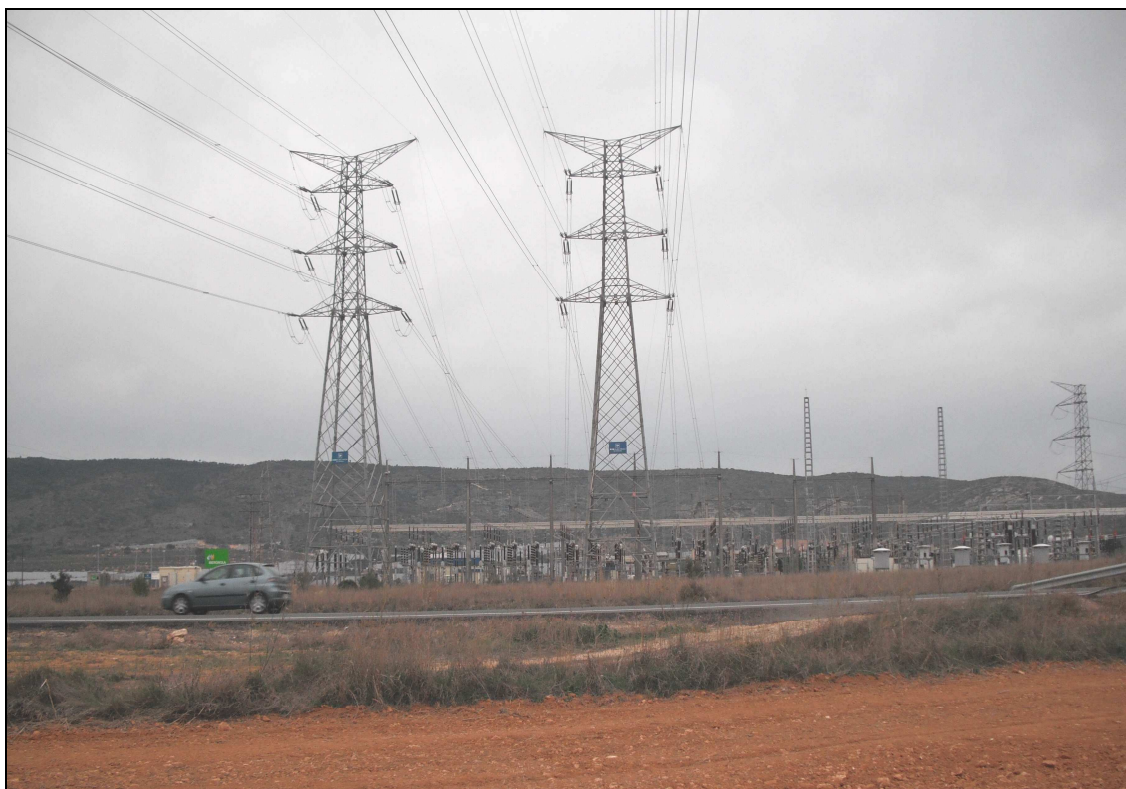
Panorámica del área de intervención.
