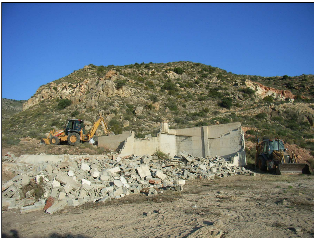
Vista del proceso de demolición de El Palomar.
