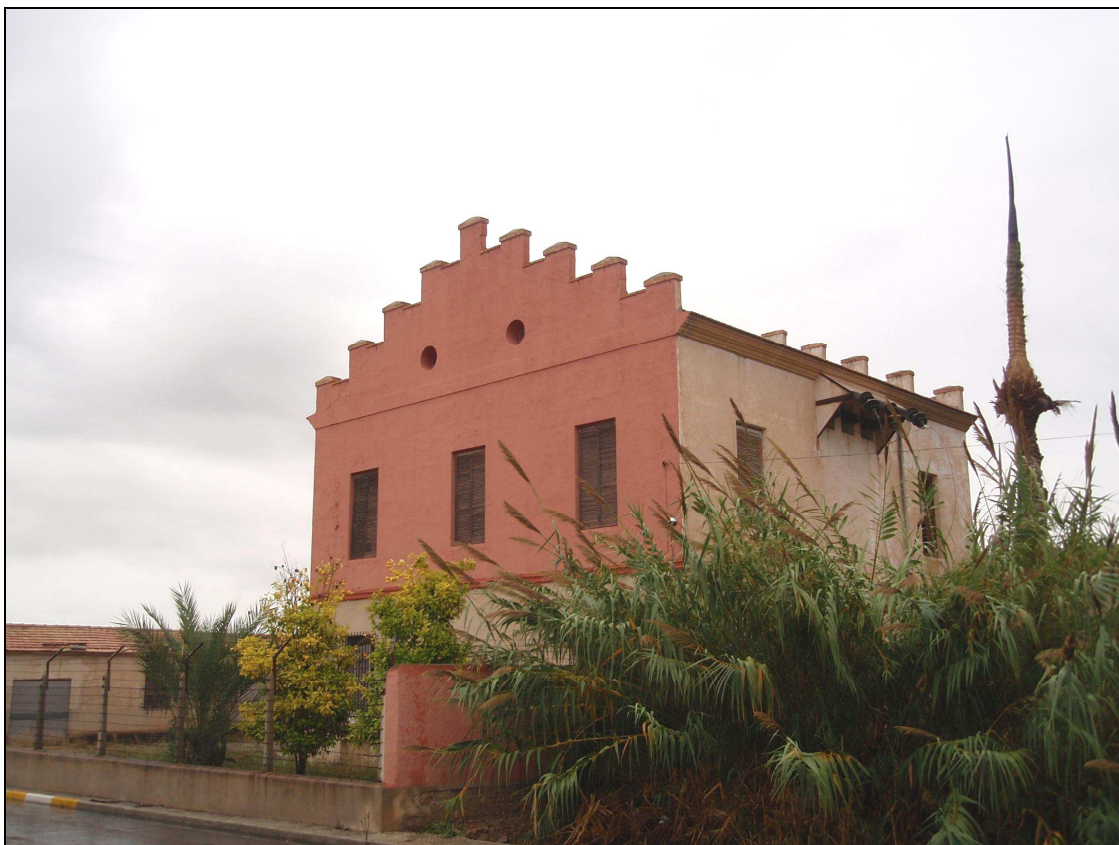
Vista de la subestación de la carretera de Matola.
