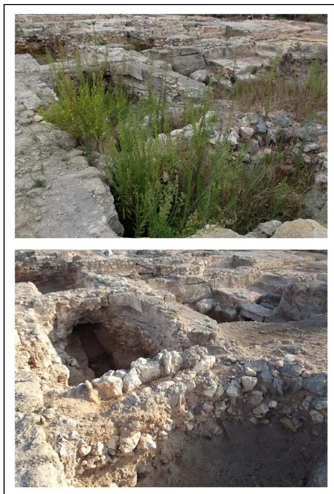
Imágenes de parte de las balnea orientales antes y después de la intervención.
