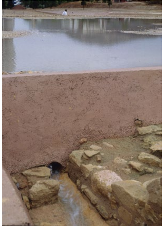
Fig. V.160: Inundación en el yacimiento y efecto de protección de los taludes.
