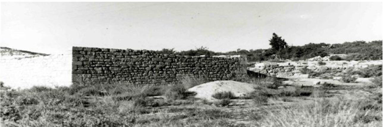
Fig. V.115: Torre X (Puerta Oriental) en 1986. Reconstruida en 1980 con pequeño-mediano aparejo. ATM.
