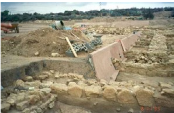
Fig. V.161: Construcción de los taludes de protección. ATM.
