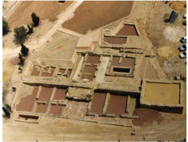
Fig. V.202: La “Domus del Peristilo” tras los trabajos de consolidación. 1996. ATM.
