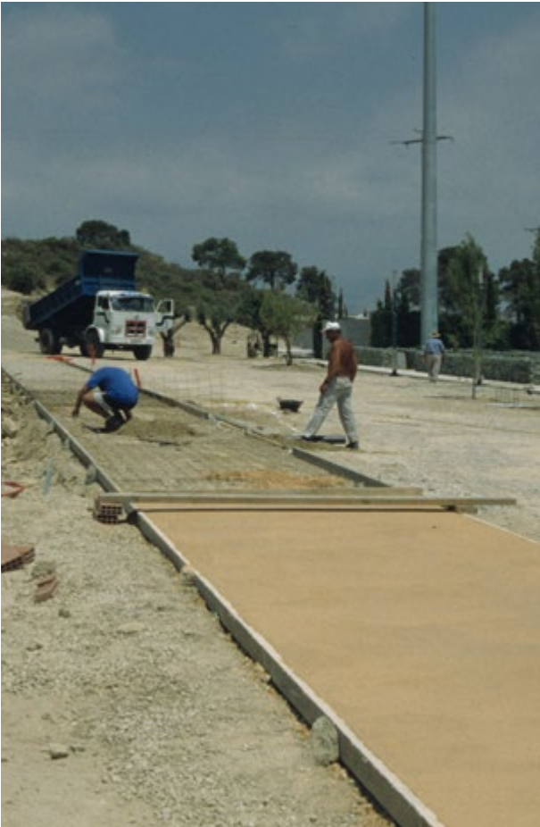
Fig. V.165: Construcción de senda de hormigón. ATM.
