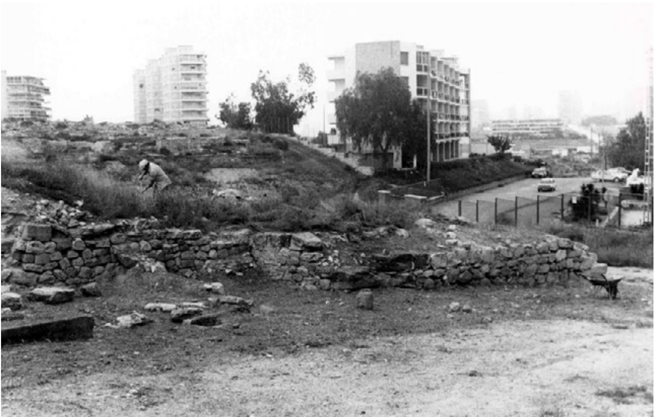
Fig. V.113: La torre II antes de su recerimiento en 1980. Compárese con la fotografía anterior. ATM.
