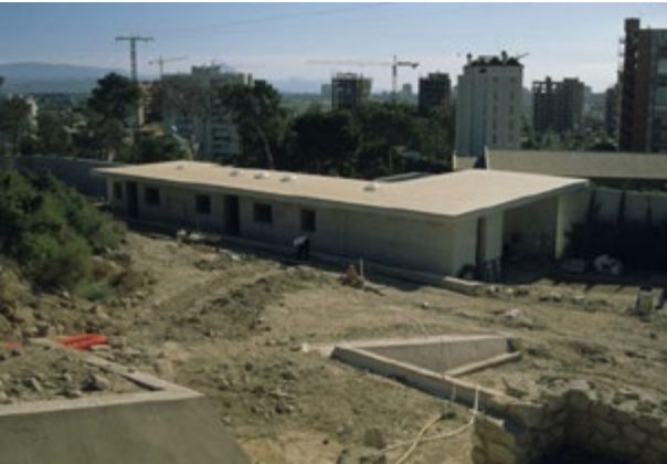
Fig. V.167: Construcción del edificio de entrada al yacimiento. ATM.
