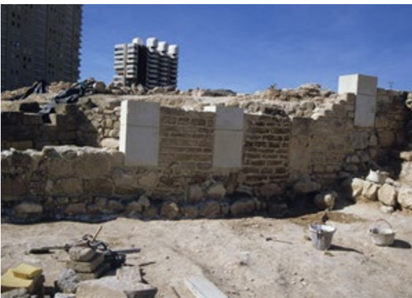
Fig. V.154: Muro de opus africanum (B4) consolidado en 1994. Vid plano supra. ATM
