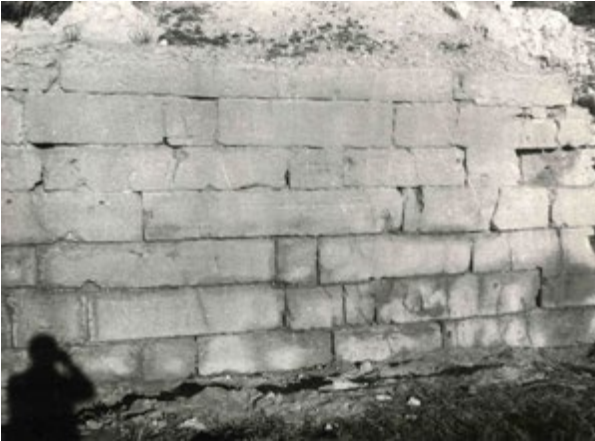
Fig. V.76: Paramento SE de la torre II o del Toro. En la base se practicó el sondeo I descubriendo las dos hiladas inferiores. ATM.
