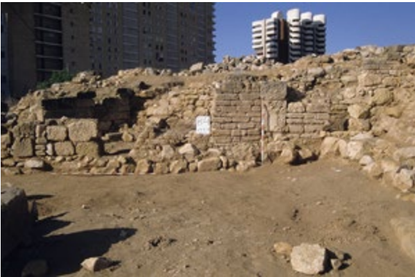
Fig. V.153: Estado de conservación del muro de opus africanum (B4) en 1994. Vid plano en fig. V.151. ATM
