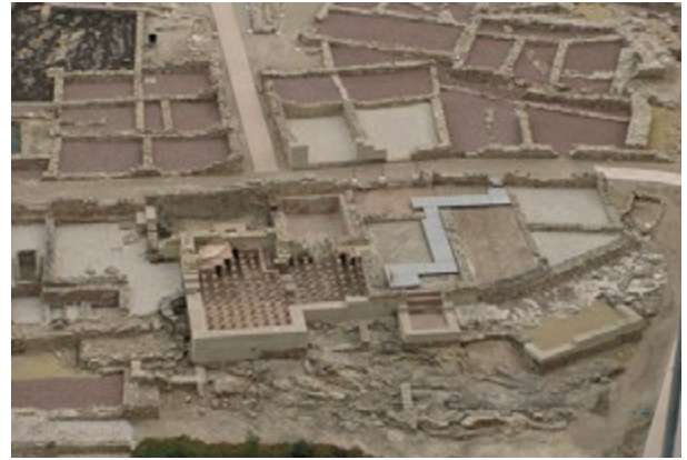
Fig. V.186: Las Termas de la Muralla en 1994 y en 1998. Obsérvese la reposición del muro exterior en sillería y las columnitas de ladrillo del hypocaustum del caldario y del tepidario. ATM.
