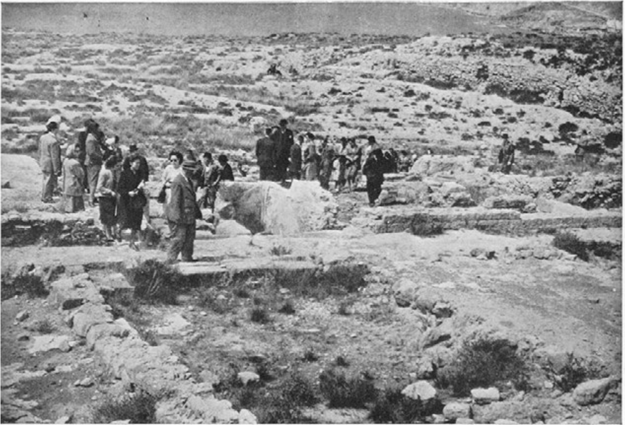
Fig. V.41: Paseo de los asistentes al IV Congreso Arqueológico del Sudeste al Tossal de Manises. Mayo de 1948 El grupo se encuentra atravesando las Termas de la Muralla. Al fondo, totalmente libre de construcciones interpuestas, la bahía de la Albufereta. Junta de Turismo de Cascais.
