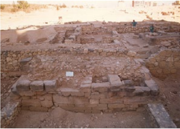
Fig. V.137: Torre I en el tramo 2 de la muralla. Obsérvese la disposición de los sillares a tizón que penetra en el relleno del zócalo. ATM.
