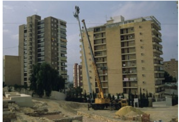
Fig. V.168: Instalación de uno de los postes de iluminación. ATM.
