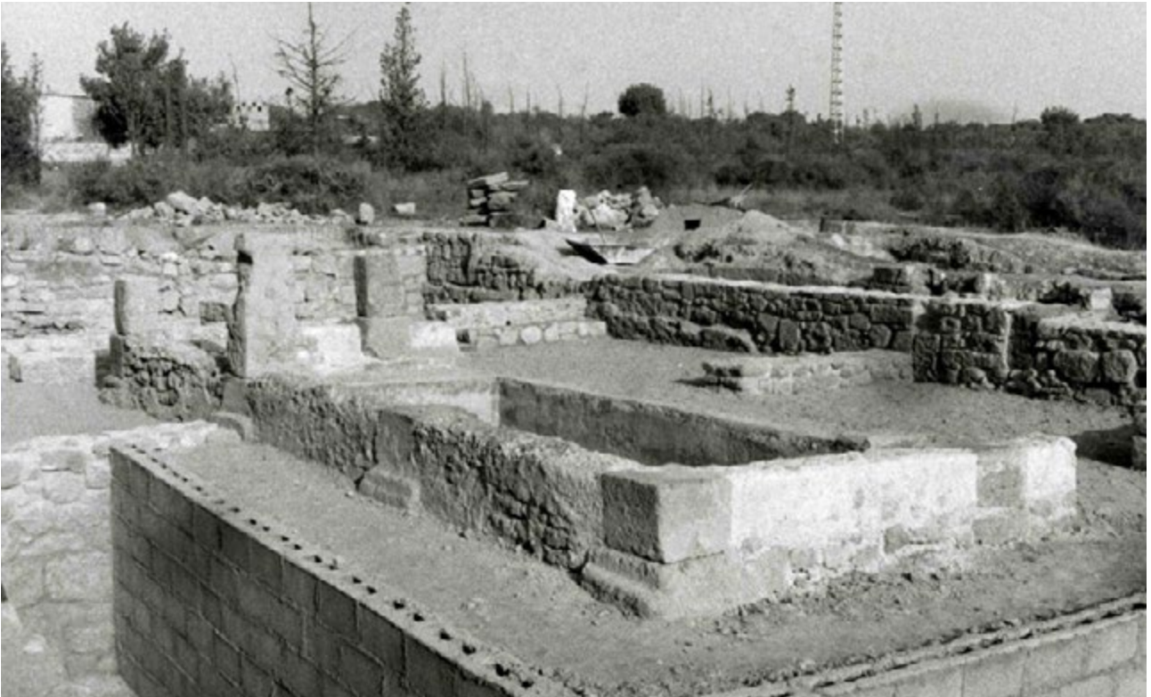
Fig. V.114: Muro de contención de ladrillos de hormigón en la Domus del Peristilo. 1980. ATM.
