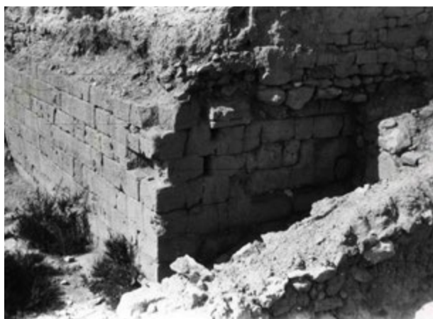
Fig. V.19: "Torre del toro" detalle. Véase el muro de mampostería que sobresale de la hilada superior de sillares. ATM.
