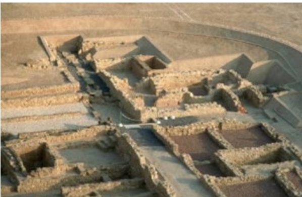
Fig. V.159: Construcción de taludes de protección de los frentes de tierra para proteger la zona de las Termas de Popilio. ATM.
