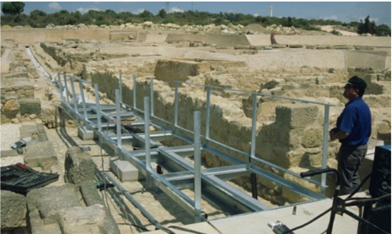
Fig. V.166: Construcción de pasarela en la calle de Popilio. ATM.
