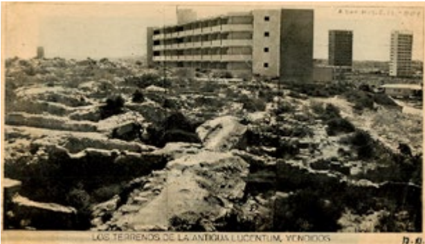
Fig. V.60: Noticia de la venta de terrenos en el Tossal de Manises. 17 de noviembre de 1965. Al fondo el edificio “Lucentum” recién construido. Diario Información.
