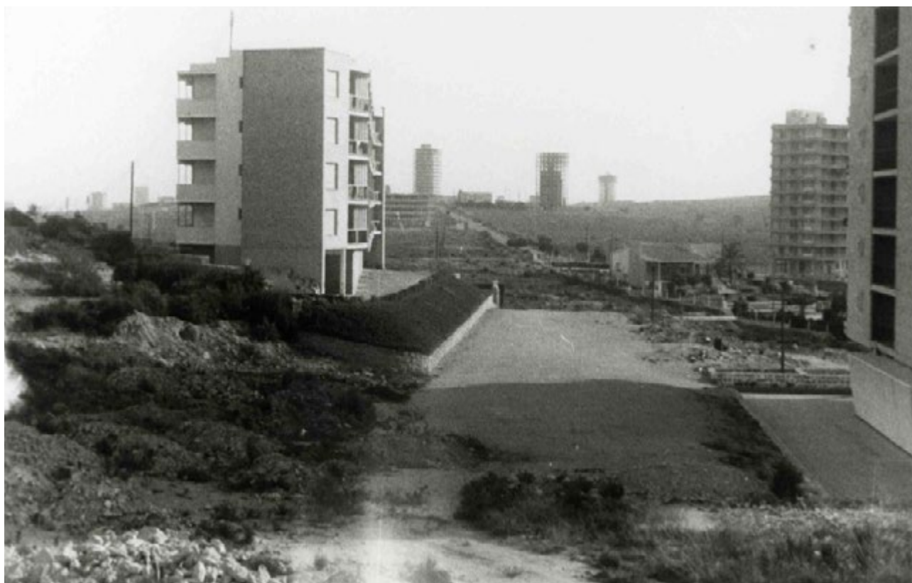
Fig. V.63: Tossal de Manises, diciembre de 1965. Edificios Lucentum y Panorama a la izquierda y derecha respectivamente, recién terminados. Son las primeras construcciones que amenazaron directamente el yacimiento. Foto tomada durante las excavaciones dirigidas por M. Tarradell. ATM.
