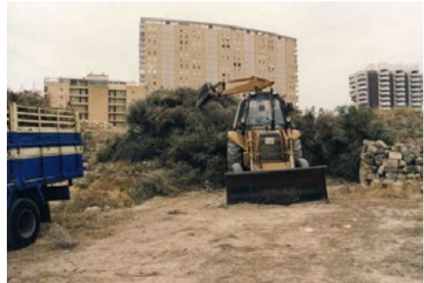
Fig. V.148: Limpieza de vegetación. 1993. ATM.
