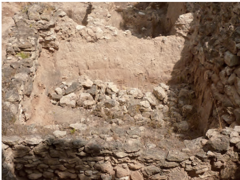
Excavación por debajo de la cota de cimentación. Colapso de fábrica
