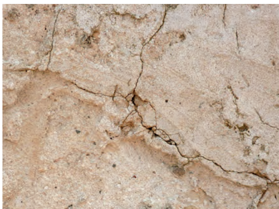
Fragmentación de revestimiento por cambios de temperatura y humedad
