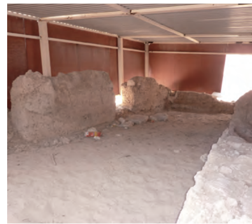
Protección fábrica de adobes con casetón de tableros y chapa. Interior
