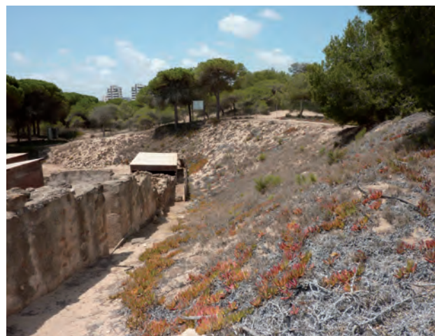
Contención de arenas mediante plantas tapizantes
