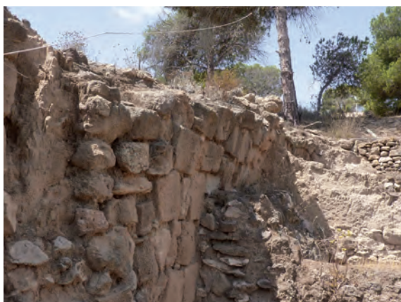
Fabrica con desplome o pérdida de verticalidad
