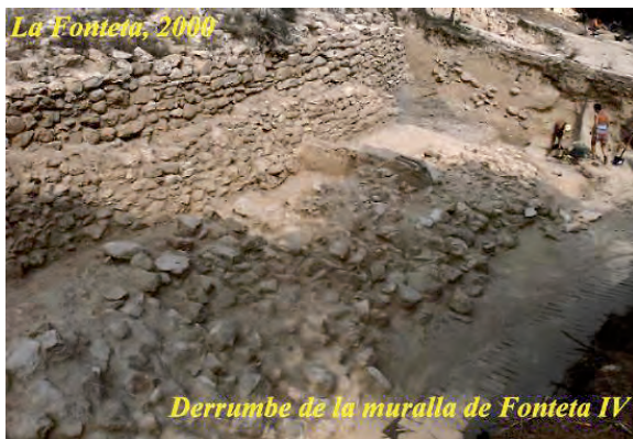
Cortes 54-1. Derrumbe del zócalo de piedra de la muralla. Excavaciones del equipo de González Prats
