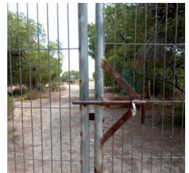
Vallado del recinto. Puerta principal del sector mayor. Detalle
