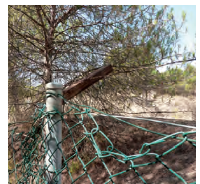
Vallado del recinto. Detalle superior con varias reparaciones
