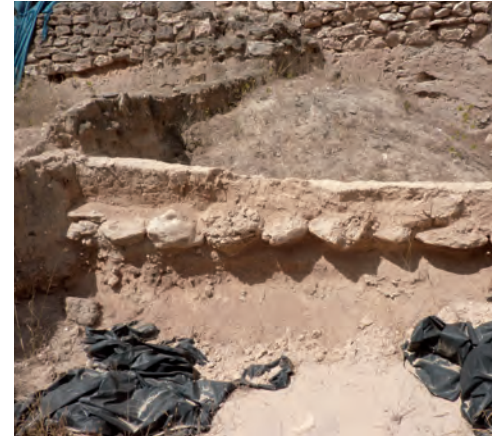
Fábrica de adobes que había sido cubierta con plástico. 2012
