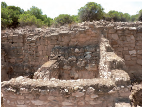
Degradación de estructuras por ensuciamiento y lavado diferencial
