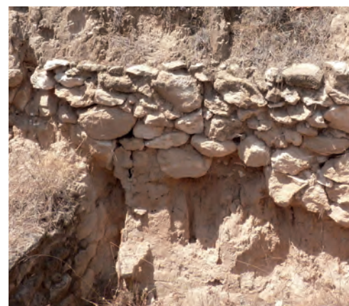
Descalce de una fábrica
