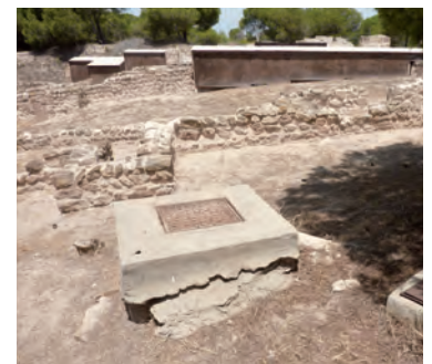
Arquetas de acometida y tomas de agua
