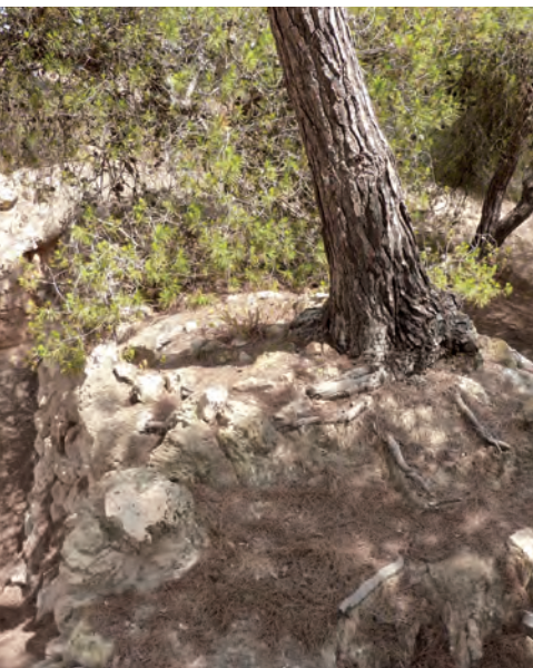
Alteración por presencia de organismos vivos. Árbol enraizado en fábrica
