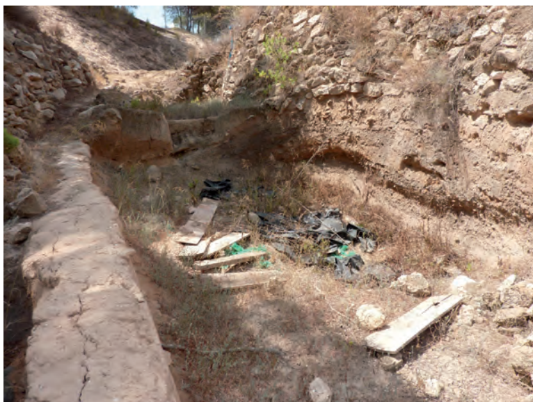
Cortes dejados por la excavación sin estabilizar. Muy degradados
