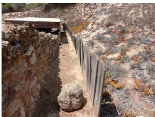
Contención de arenas mediante tablestacas de madera
