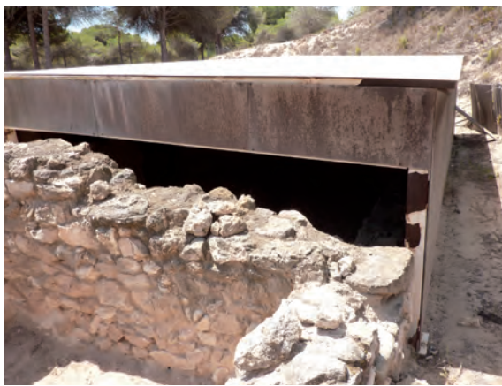
Protección fábrica de adobes con casetón de tableros y chapa. Exterior
