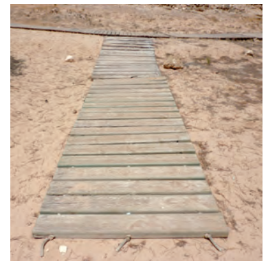
Pasarela de madera. Entronque con el anillo de La Rábita
