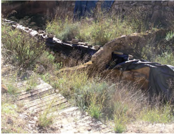
Protección fábrica adobes con cubierta de plástico. 2008
