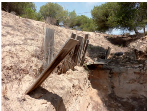
Contención de arenas mediante tablestacas de madera y chapas metálicas
