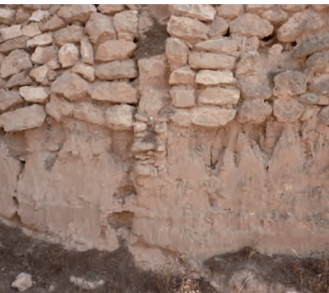
Degradación estructuras por humedad de filtración
