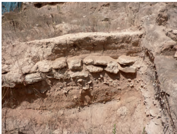
Descomposición estructuras por humedad capilar
