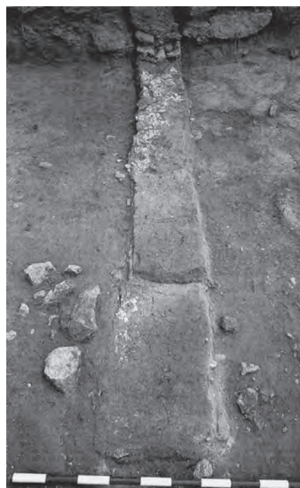
Muro de tapial MR67, tabique interno de la estancia KM
