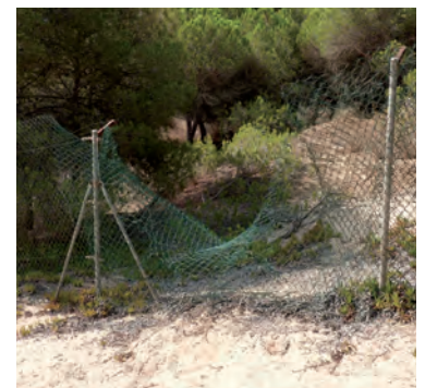
Vallado del recinto. Sabotaje de la malla, lado oriental
