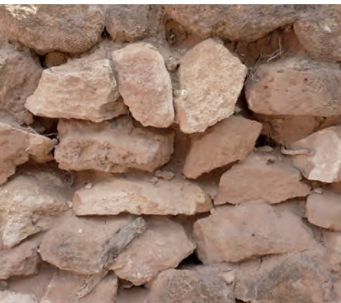
Degradación estructuras por pérdida de argamasas de asiento y rejuntado
