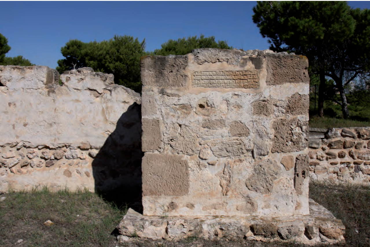
Muro de La Rábita Califal de Guardamar con copia de la lápida fundacional integrada (GARCÍA MENÁRGUEZ, 2010, pág.154)
