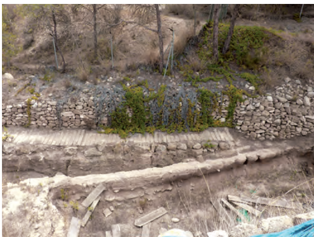
Contención de arenas mediante muros de piedra y plantas tapizantes
