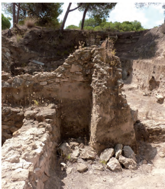
Desprendimiento de bloques pétreos de una fábrica
