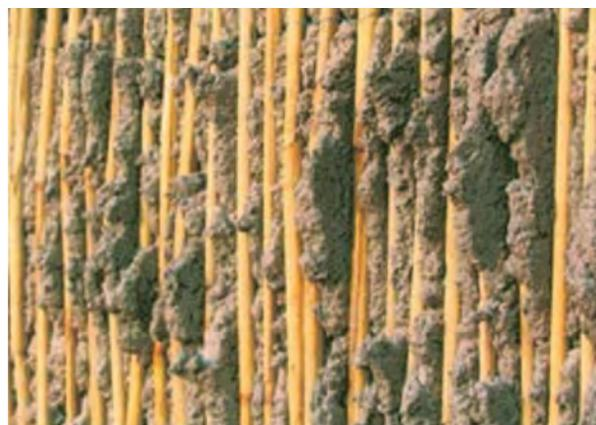
Figura 45. Construcción de una pared mediante un entramado de carrizo relleno de barro, similar al utilizado en las construcciones del Cabezo Pardo (Sooster, 2008: 21).
