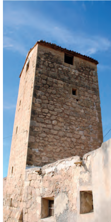
La Torre Boter, uno de los mejores ejemplos sin restaurar de las torres de refugio de la Huerta de Alicante.
