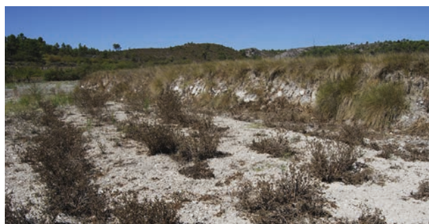
Figura 2. 110. Vistas de El Barranc de El Molinet y de un abancamiento realizado en las margas miocenas en el que se observa un nivel superior con abundante materia orgánica.
