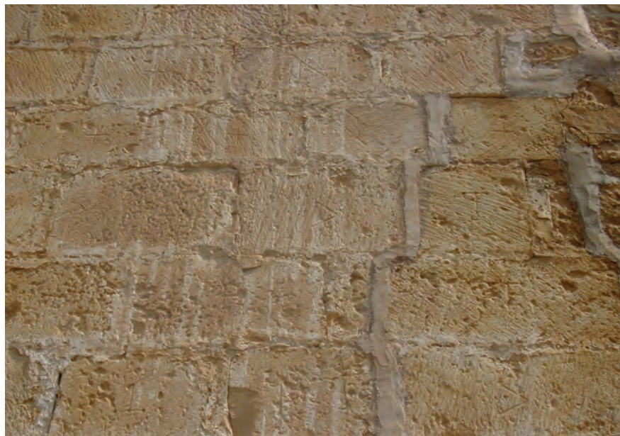
Figura 8. Marcas de cantero realizadas en la torre central de la muralla.
