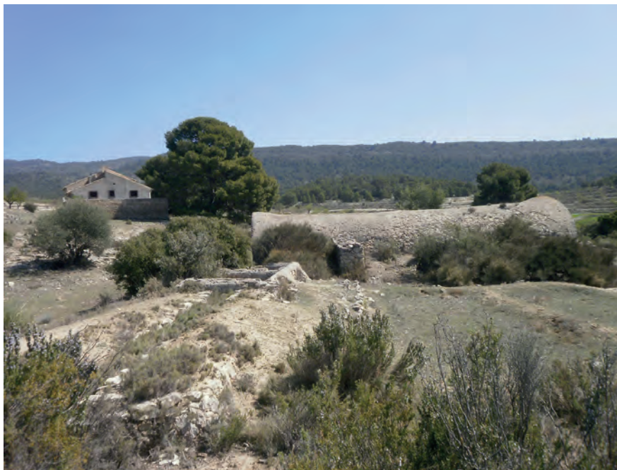
Figura 6. Casa del Esquinal con su aljibe de grandes dimensiones en primer término.
