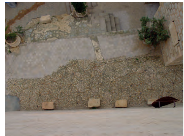
Figura 5. Vista cenital de uno de los pavimentos de cantos rodados y fragmentos de tejas existentes en el patio del castillo.
