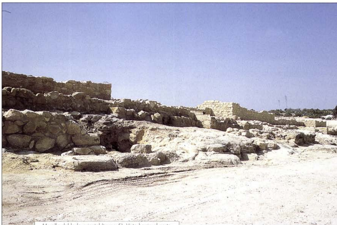
Muralla del lado oriental (tramo 5). Vista hacia el norte
