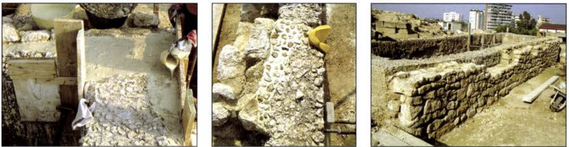
Secuencia de la intervención en la “gran cisterna” (num. 6). Restitución parcial de hormigón de cal
