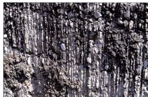
Detalle de las huellas del panel de cañas utilizado como encofrado (molde) del opus caementicium que forma el vaso de la cisterna num. 6
