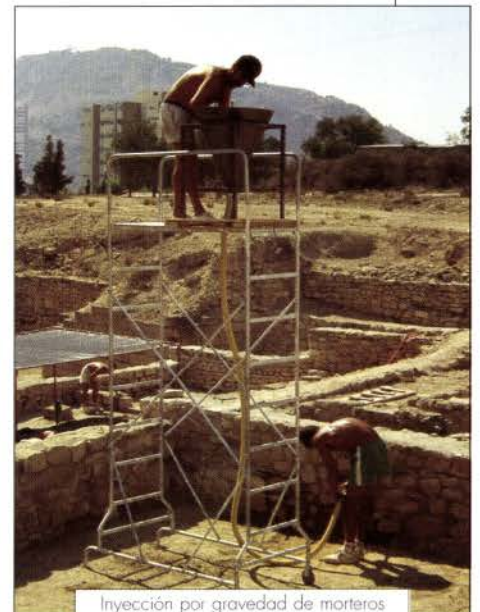
Inyección por gravedad de morteros consolidantes en núcleos de muros
