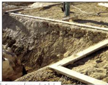
Preparación de los cortes de tierra en forma de talud
