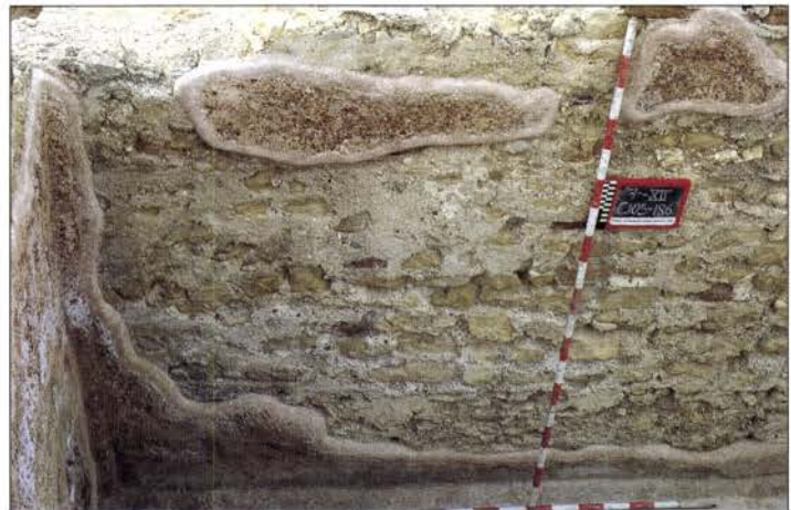
Cisterna anterior con el enlucido consolidado mediante cordones de mortero perimetrales
