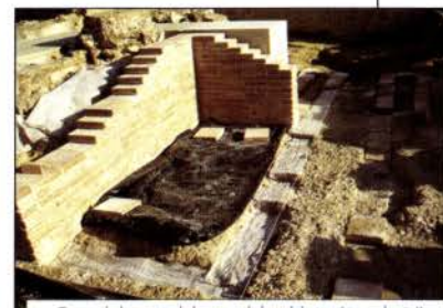
Consolidación del piso del caldario (ángulo N) y canal del horno en ejecución. 1995
