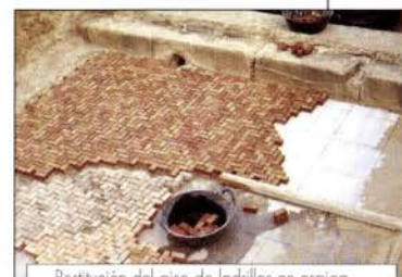
Restitución del piso de ladrillos en espiga del caldario de las Termas de Popilio. 1998
