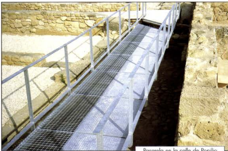
Pasarela en la calle de Popilio
