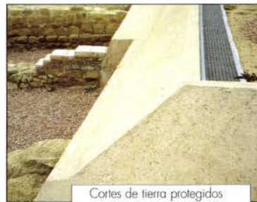
Cortes de tierra protegidos y canal de drenaje instalado
