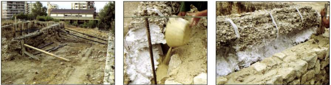
Secuencia de la intervención en la “gran cisterna” (num. 6). Restitución parcial de hormigón de cal
