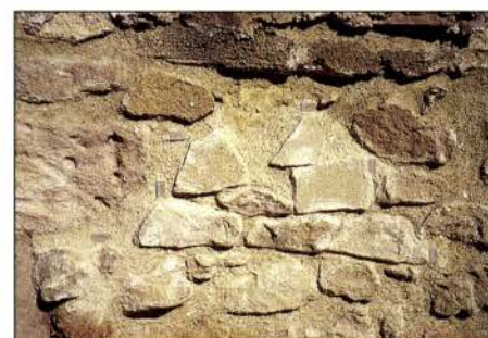
Trabajos de consolidación. Señalización exterior de la restitución
