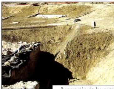
Preparación de los cortes de tierra en forma de talud
