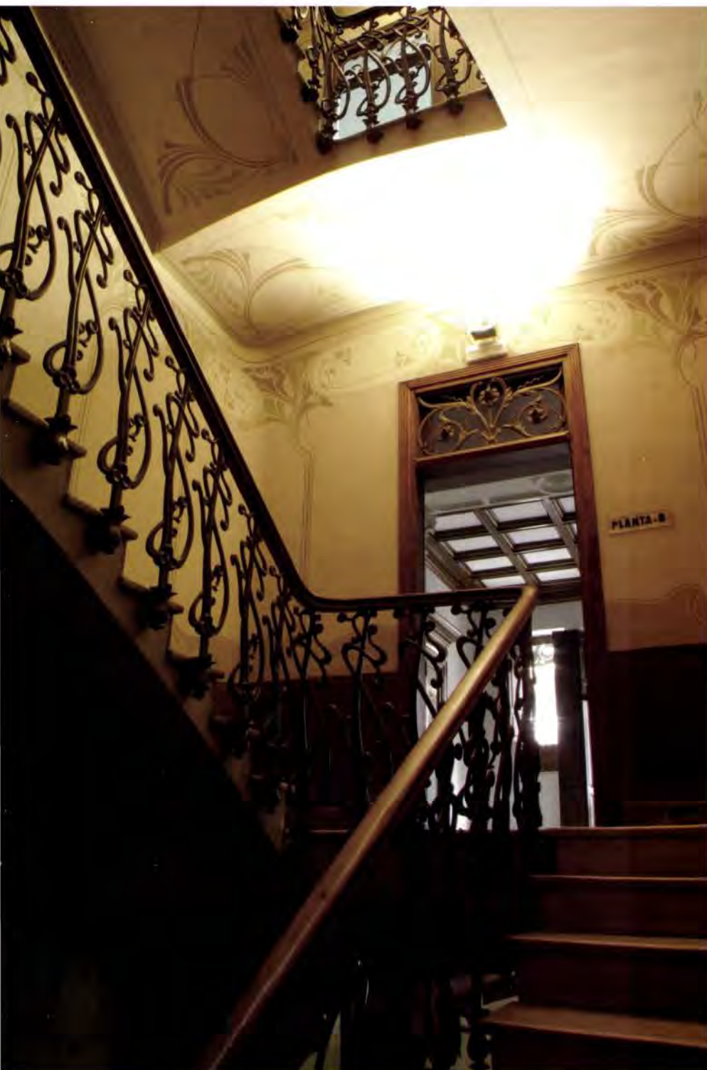
Escalera con balastrada de fundición. Edificio modernista de la calle Juan Cantó núm. 2 (Conservatorio Municipal de Música y Danza)
