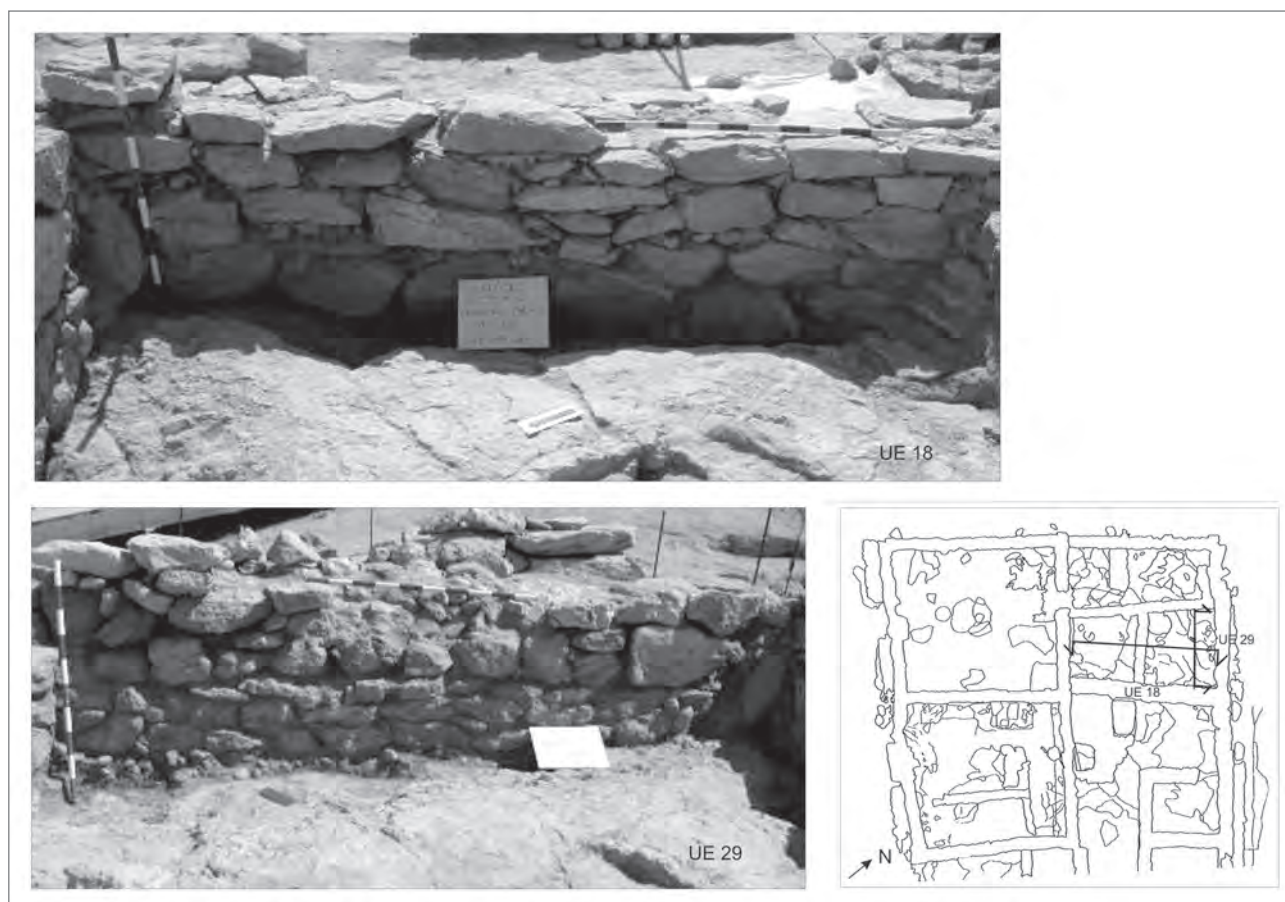
Figura 205. En la parte superior vemos un muro contruido con lajas; es una técnica que hasta el momento sólo se ha documentado en el lagar de la casa del cura. En la parte inferior vemos un ejemplo del paramento fabricado con piedra local que se utiliza en los restantes muros ibéricos.
