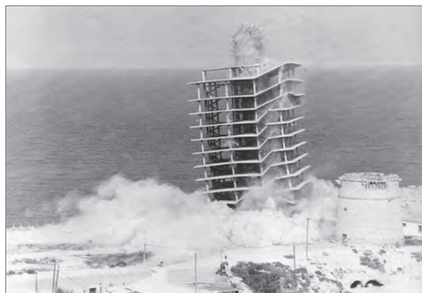
Figura 43. Derribo de la estructura del edificio.
