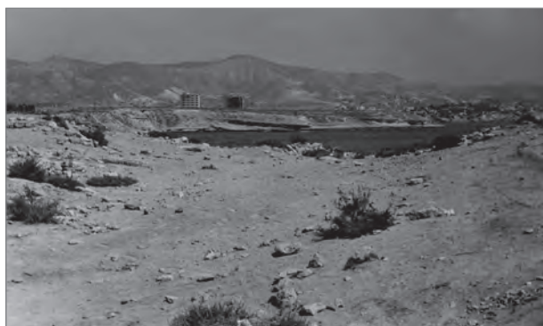
Figura 51. Estado de conservación de la zanja transversal de Figueras en 1973.
