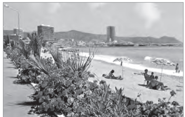
Figura 42. Imagen típica del Clot de l'illot en los años 70 con la estructura del edificio al fondo.
