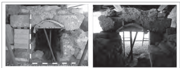
Figura 243. Vistas del arco del praefurnium desde el interior y el exterior del horno.
