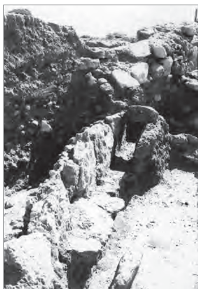
Figura 72. Detalle del canal situado bajo el muro curvo.
