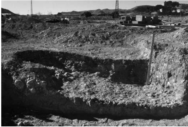
Figura 61. Estructura 1 tras su excavación
