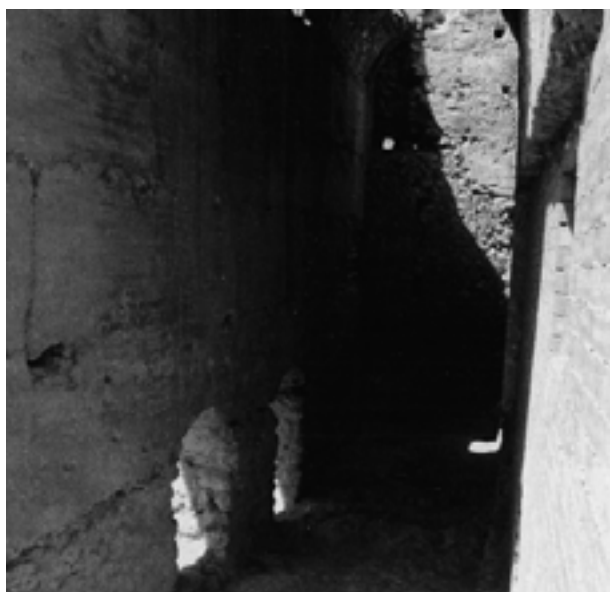
Figura 1.10. La Torre Grossa y dos vistas de los lienzos después de la intervención.
