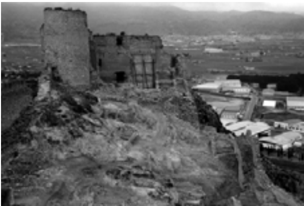
Figura 3.101. Sector norte del Castell de Castalla, con el Palau y estancias propiamente feudales del castillo.
