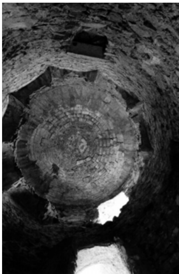
Figura 2.23. Vista de la cubierta hemisférica rebajada, de ladrillo puesto de canto y posteriormente doblado en su intradós por otros colocados a panderete de la torre Suroeste (Foto: Autor).
