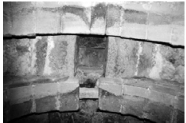
Figura 3.55. Brocal o boca del aljibe que se ubica entre las tres arcadas de sillares de la zona norte de este depósito.
