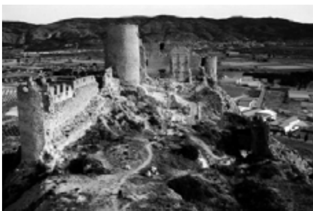
Figura 3.9. Estado previo del castillo antes de la intervención en su recinto interior.
