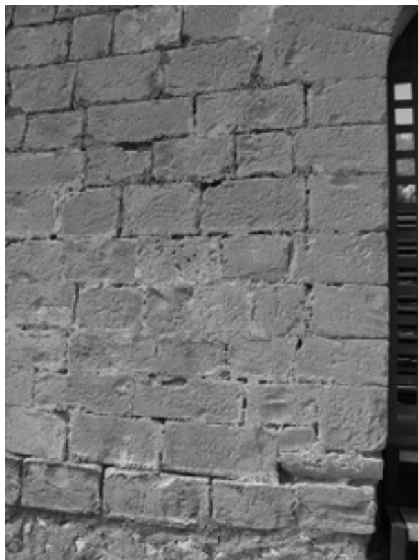
Figura 12.3. Sillares con marcas de cantero. Castell de Castalla.
