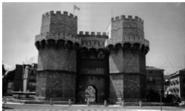
Figura 2.28. Vista general de las Torres de Serrano. En su remate se aprecia la crestería almenada con aspillera integrada (Foto: R. Azuar).
