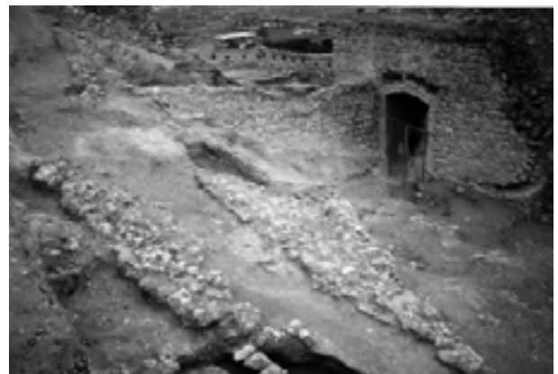
Figura 3.24. Junto al acceso a la fortificación se halla la fachada sur de un gran edificio feudal colindante con la muralla del sector noreste.
