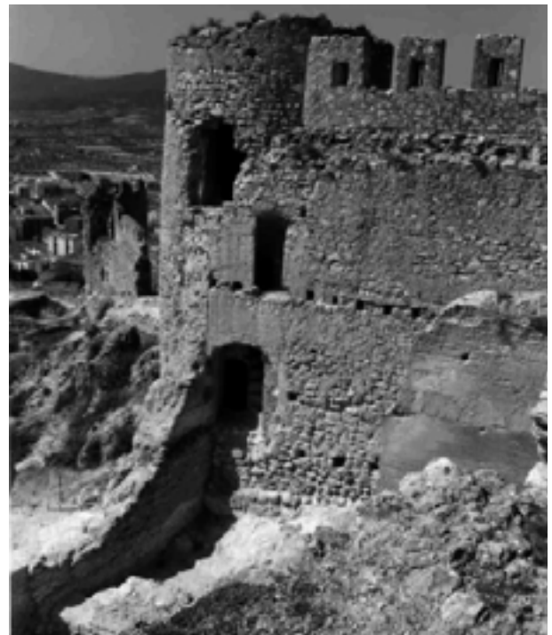
Figura 2.31. Detalle de la cara externa de la escalera de caracol. La puerta de la planta baja conduce hasta la primera planta, pero no continua la escalera hasta el paso de la segunda a la tercera planta. De esa manera, si se cerrara la puerta en la primera planta, quedaba atrancado el paso a las plantas superiores, lo que facilitaba la defensa del recinto (Foto: Autor).
