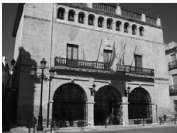
Figura 14.5. Castalla. Fachada ayuntamiento.
