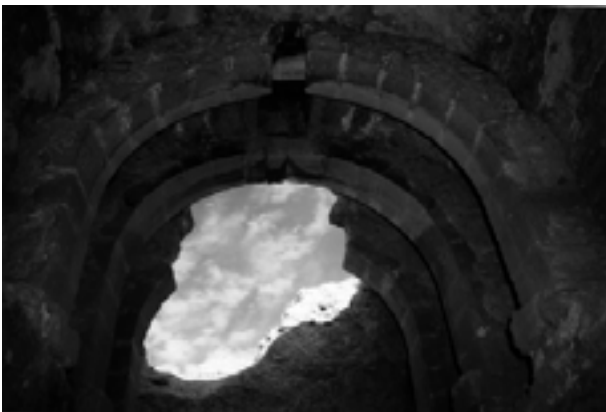
Figura 3.54. Tres arcadas en sillería que aguantan el sector norte del aljibe del recinto fortificado.
