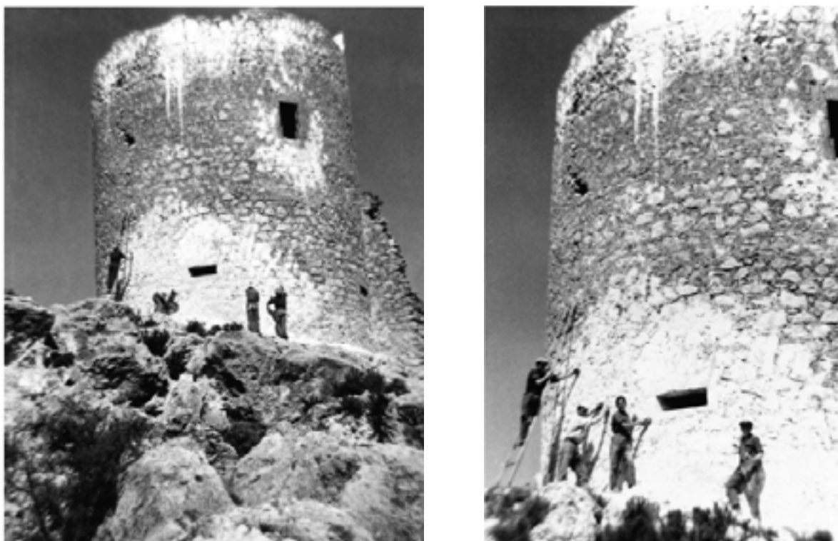
Figura 10.20. Desencalado de la Torre Grossa en 1961.
