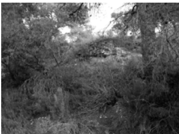
Figura 19.3. Restos de la torre de la alquería de Cabanyes (Foto: ARPA Patrimonio).
