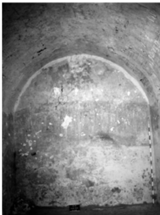
Figura 10.12. Graffiti localizados en la pared Este aljibe interior del Palau.
