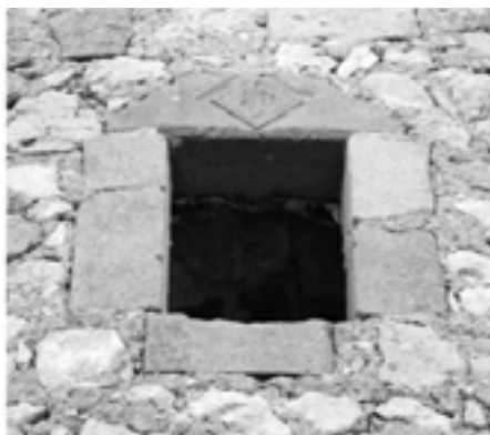
Figura 10.22. Situación de la ventana Oeste de la Torre Grossa dentro del Castell de Castalla
