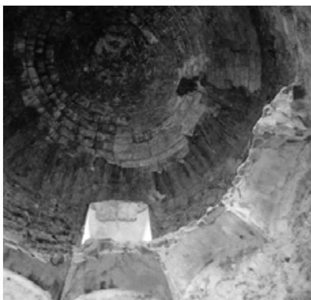
Figura 1.9. Torre Prima y bóvedas del Palau sin intervenir. 1986.
