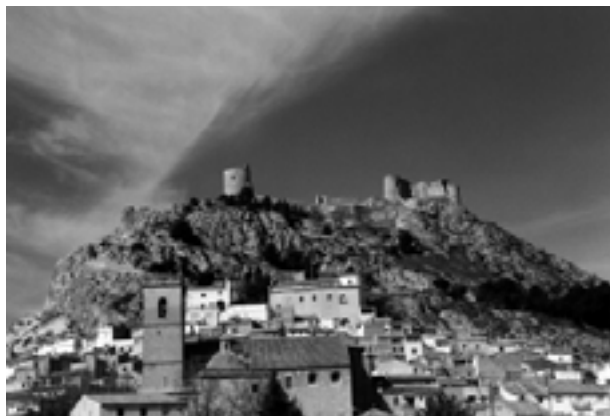
Figura 3.83. Vista panorámica del Castell de Castalla antes de su restauración.
