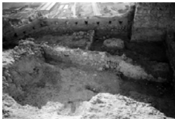
Figura 3.109. Aspilleras fusileras localizadas en el tramo de muralla nororiental del castillo, antes de llegar al Palau .
