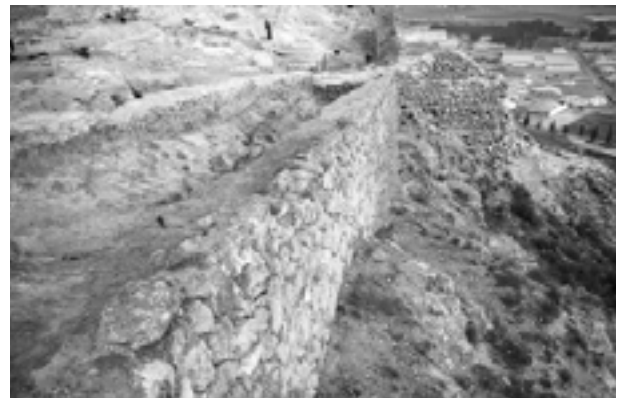
Figura 3.74. Muro de contención construido hacia los años 20-30 del siglo XX, que cegaba la línea de muralla oriental en el sector sur de la fortificación.
