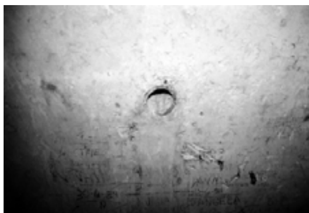
Figura 3.77. Detalle de la tubería de entrada de agua al aljibe del Palau localizada en la zona sur-este de la bóveda de esta cisterna.
