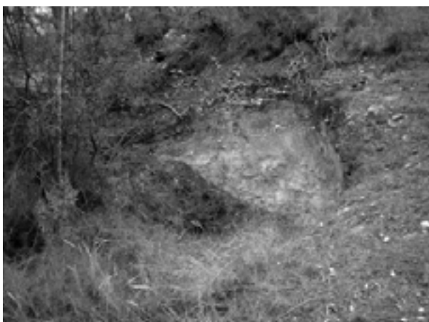
Figura 3.115. Hornos circulares para yeso localizado no muy lejos de la parte superior de la alquería de la Torre de Cabanyes.
