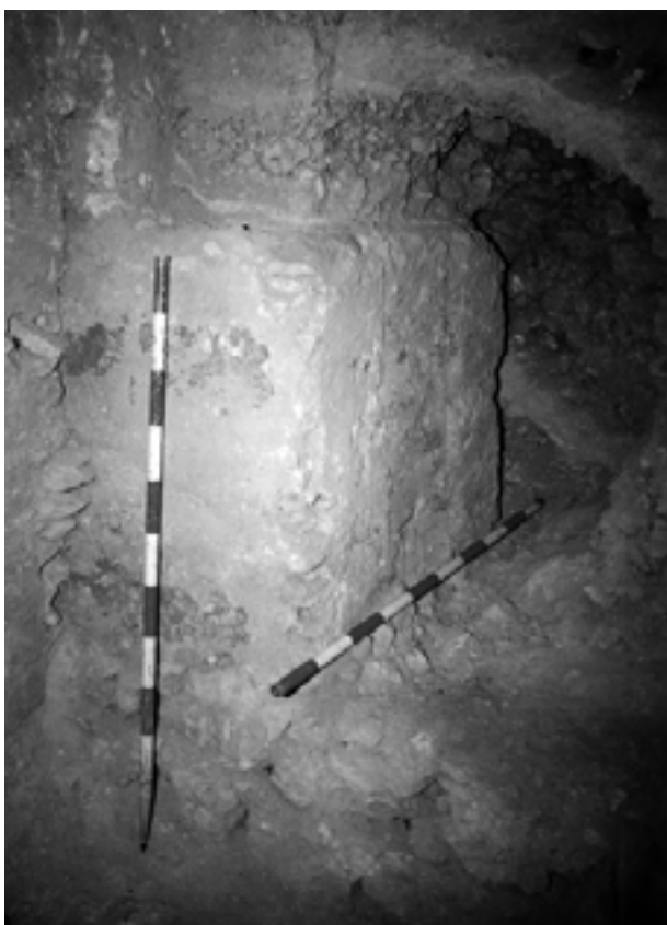
Figura 3.64. Contrafuerte de hormigón enconfrado, vinculado al aljibe.
