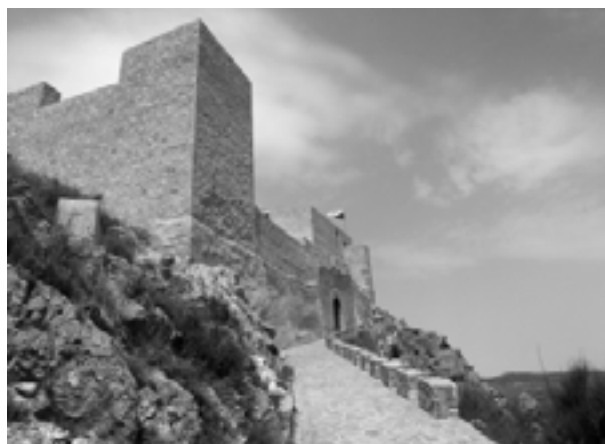
Figura 12.1. Vista general del Castell de Castalla.
