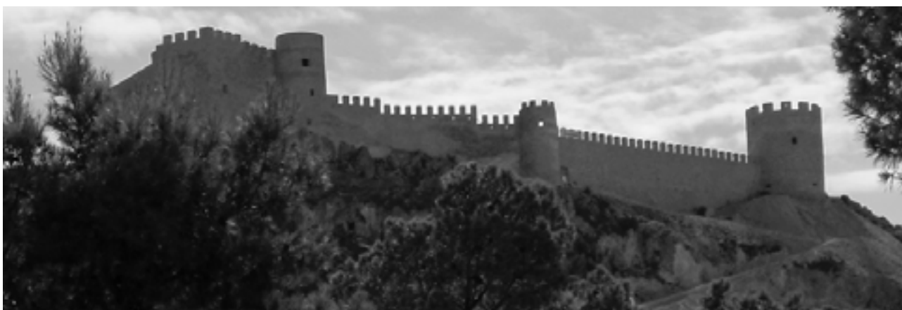
Figura 1.4. Alzado oeste del castillo después de las intervenciones arquitectónicas de los años 2003-2006.
