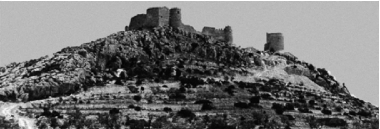
Figura 1.2. Alzado oeste del castillo antes de la intervención.
