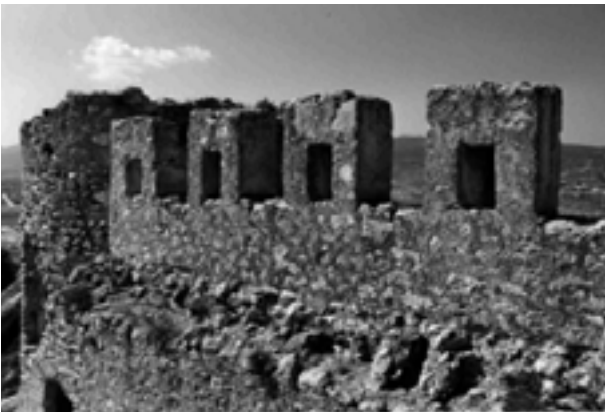
Figura 2.25. Detalle de la crestería almenada con aspillera integrada (Foto: Autor).
