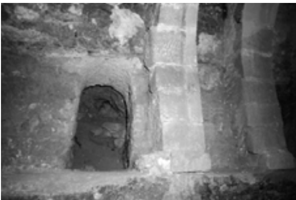
Figura 3.56. Uno de los boquetes realizado en el muro de tapial del aljibe en su frente occidental por parte de los aficionados de los años 30 del siglo XX.
