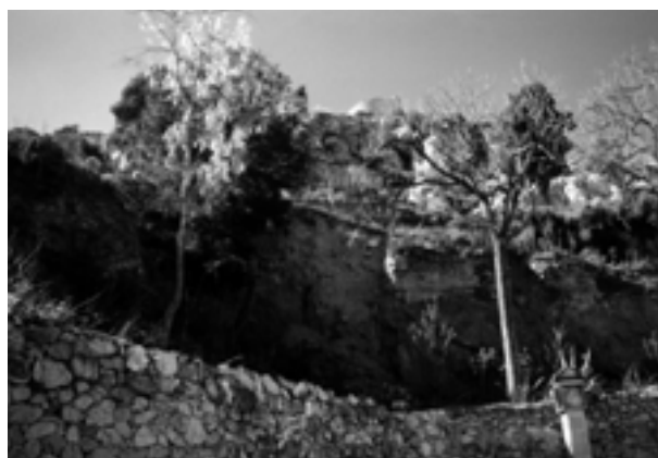
Figura 3.92. Tramos de la segunda línea de muralla junto a la Ermita de la Sang.
