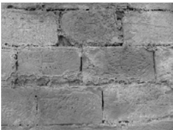
Figura 12.11. Detalles de los sillares con marcas de cantero.
