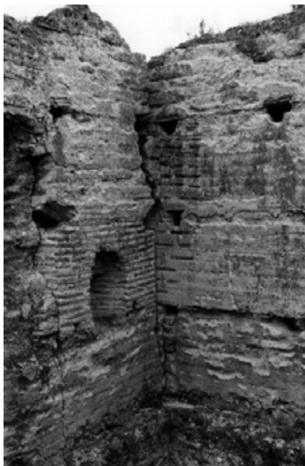
Figura 2.34. Detalle del aparejo de ladrillo en la apertura del interior del castillo de Forná (Foto: Autor).
