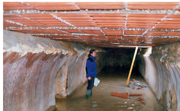
Detalle de muros de tapial con vano abierto al Norte.
