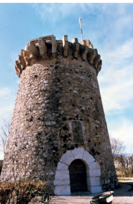
Vista general de la Torre de Piles en Oliva. (Foto: Autor).
