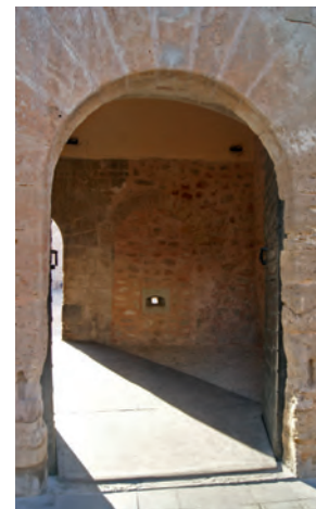
Puerta principal, interior y exterior.
