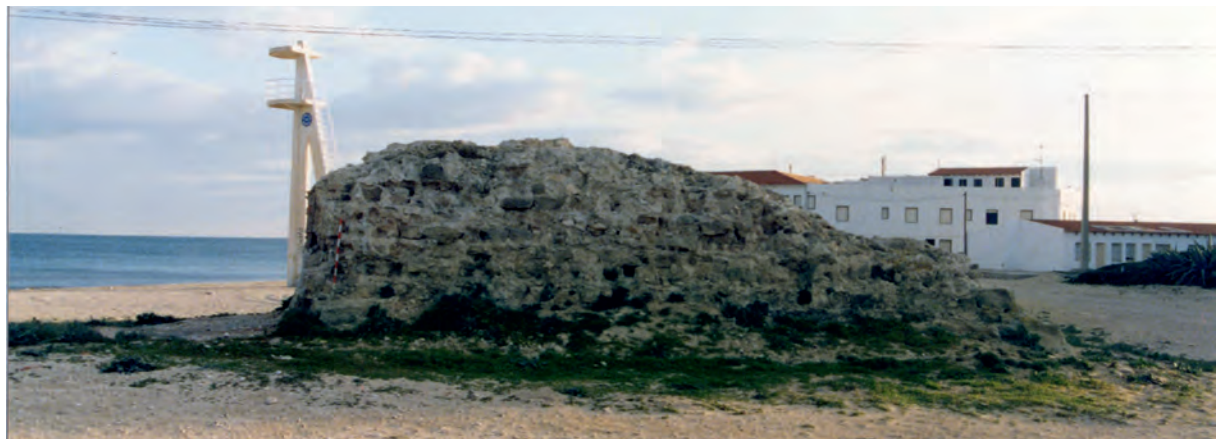
Alzado lateral de los restos conservados de la torre del Pinet (Foto Autor).
