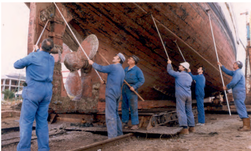
Trabajos de limpieza y reparación de una embarcación en los astilleros de Santa Pola.
