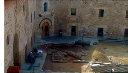
Vista cenital de la superficie Este de la Torre al SE del Patio del Castillo.
