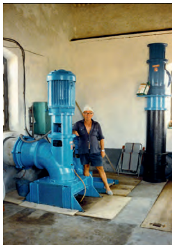
Actual bomba de elevación de agua de mar.
