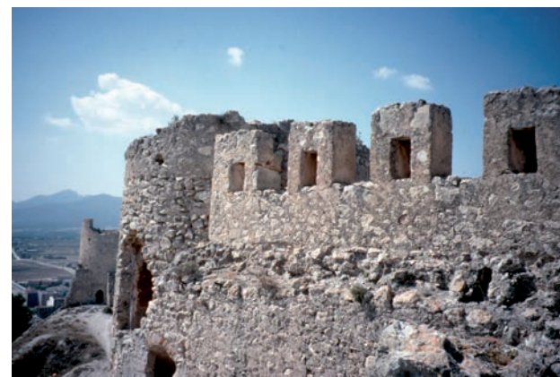
Figura 7. Detalle de la crestería aspillerada de la Domus maior del castell de Castalla.
