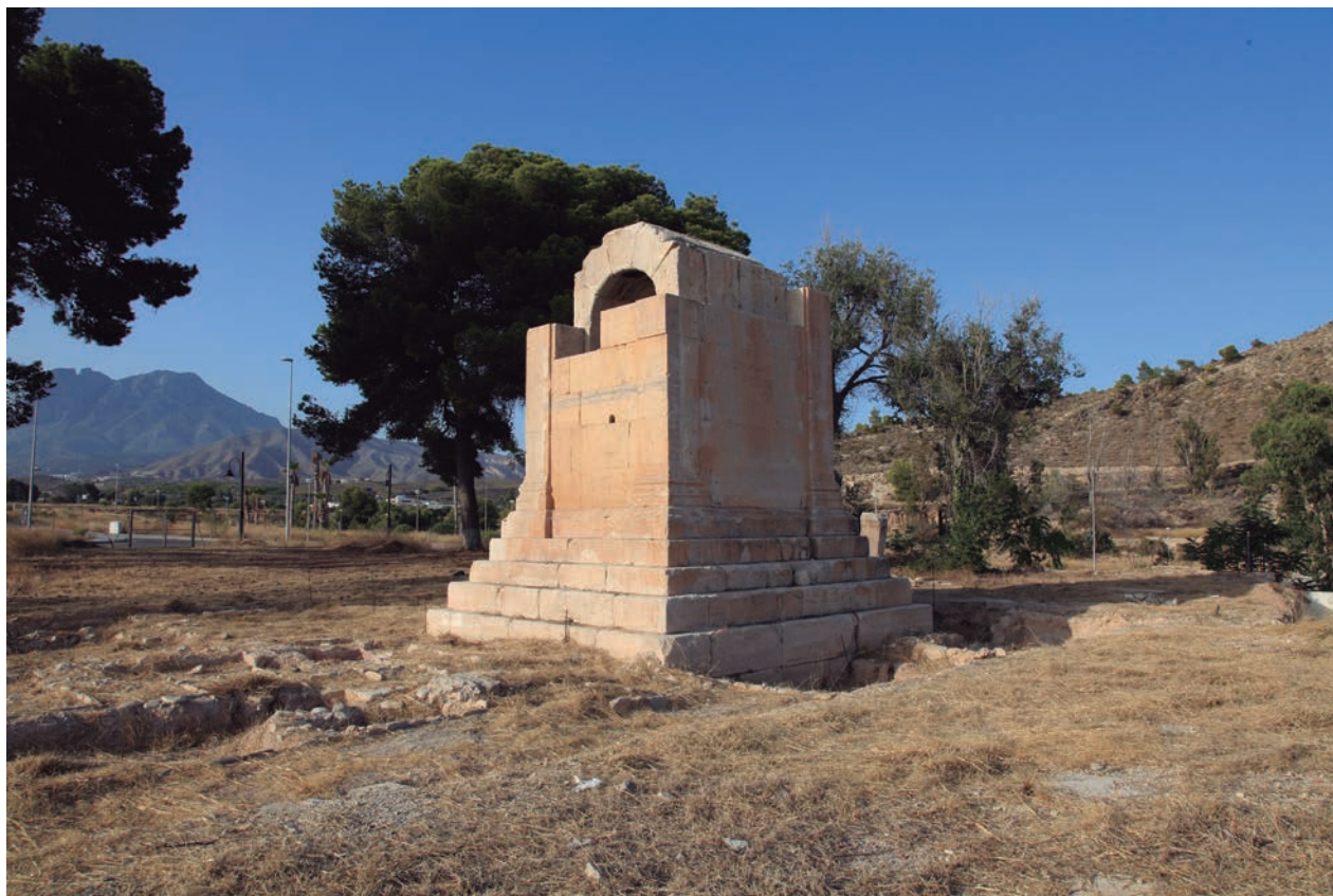
Fig. 15 Estado actual del monumento de La Vila
