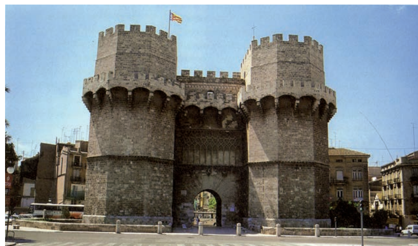
Figura 8. La Puerta de Serranos en la ciudad de Valencia con la presencia del almenado aspillerado en el remate de muros y torres. Foto: R. Azuar.
