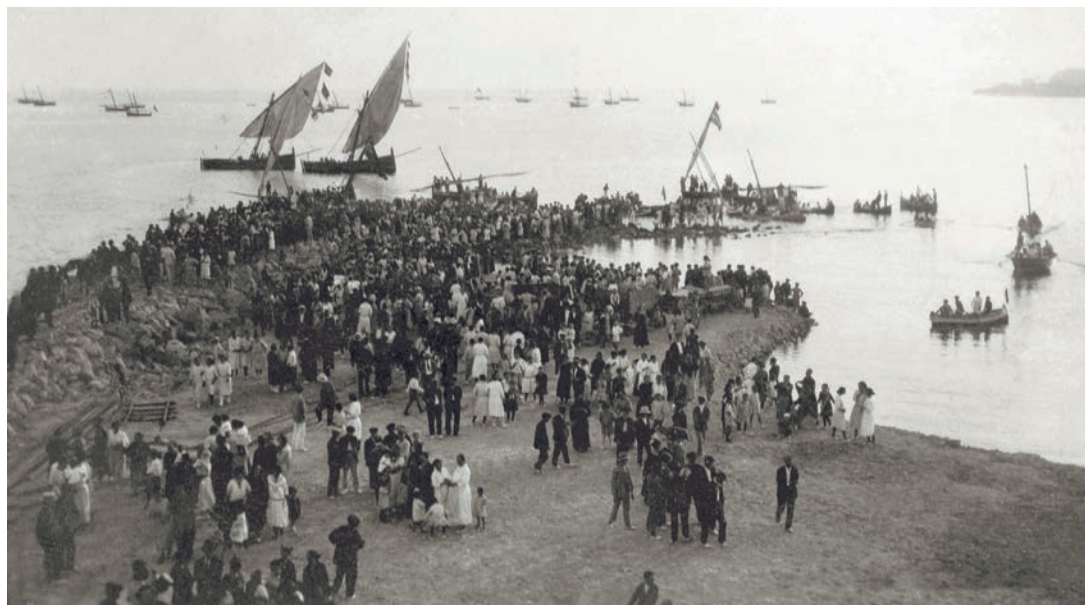
Làm. VIII. L'inici de la construcció del moll de la Vila en els anys vint del s. XX.
