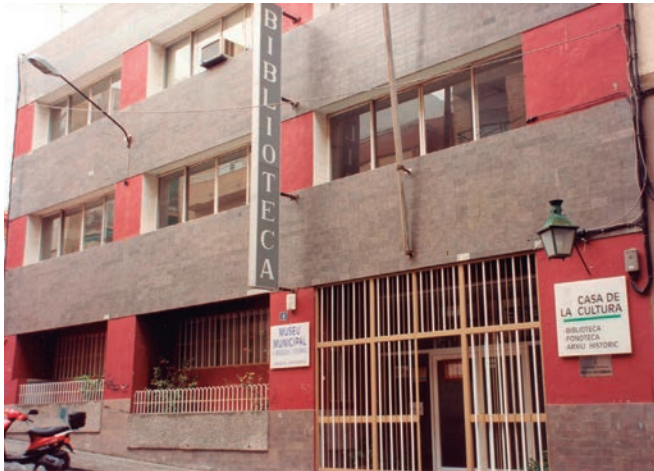
Làmina IV. Façana de la Casa de la Cultura els anys 90. La sala provisional d'Arqueologia ja s'havia traslladat a la sala d'exposicions de la planta baixa.
