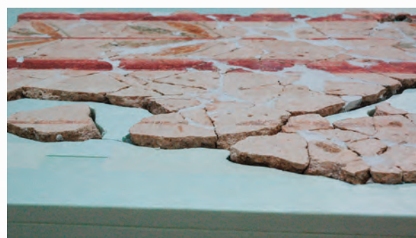
Fig. 5. Detalle donde se aprecia la técnica de ejecución del nuevo soporte de la pintura mural, compuesto por un panel rígido y dos niveles intermedios que engloban el conjunto.
