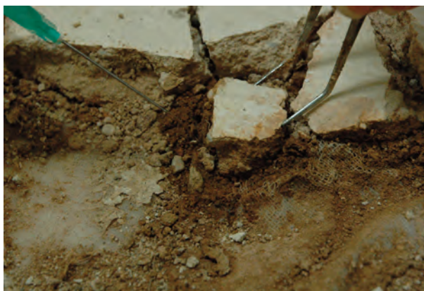
Fig. 2. Eliminación del engasado, realizado in situ como refuerzo, separando la trama con inyecciones de disolventes de alta volatilidad.
