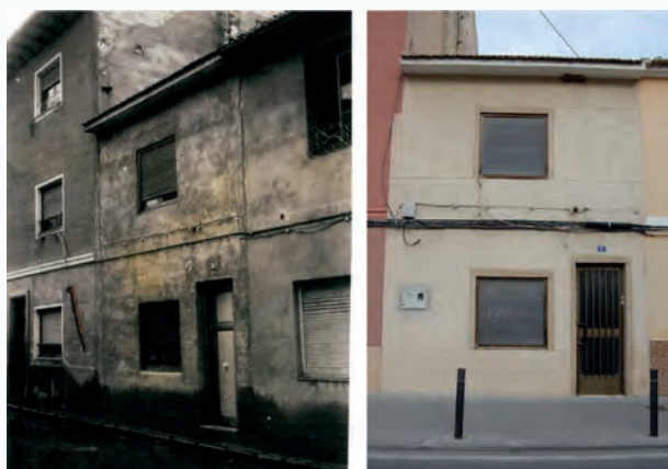
Figura 3. La casa poco antes de la reforma y en la actualidad, vistas de la fachada.
