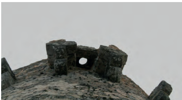
Figura 6.94: Detalle de los restos del tiro vertical de la corsera de la torre del Capd'Or.
