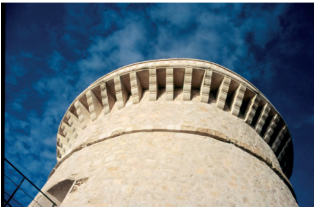
Figura 7.24: Corsera ciega de la Torre de l'Illeta dels Banyets (El Campello) propuesta por el arquitecto Marius Beviá García como solución adoptada para la restauración de la torre.
