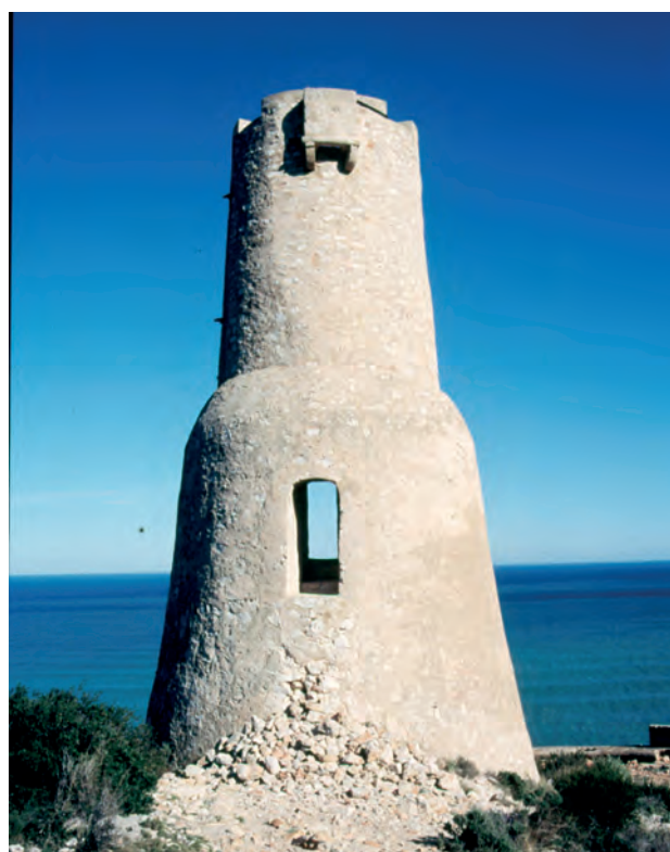
Figura 6.116: Vista general actual de la Torre del Aigüa Dolça o del Gerro.
