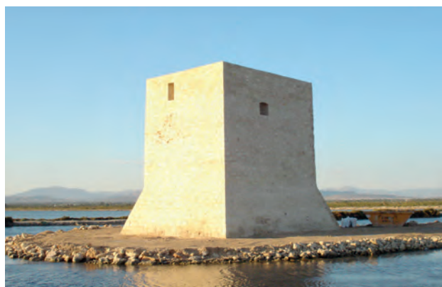
Figura 8.21: La Torre Tamarit después del proceso de restauración. Foto: Marius Bevià.
