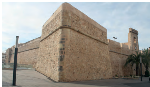
Figura 7.2: Alambor de uno de los baluartes del fortín de Santa Pola.
