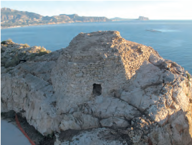
Figura 6.69: Detalle de la plataforma interior de la torre antes de su excavación por parte de la empresa Atrium Cultural Heritage Services.
