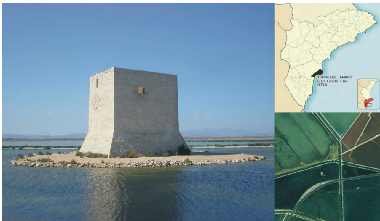
Figura 6.22: Localización y vista panorámica del estado actual de la Torre de la Albufera d'Elx después de su proceso de restauración integral.
