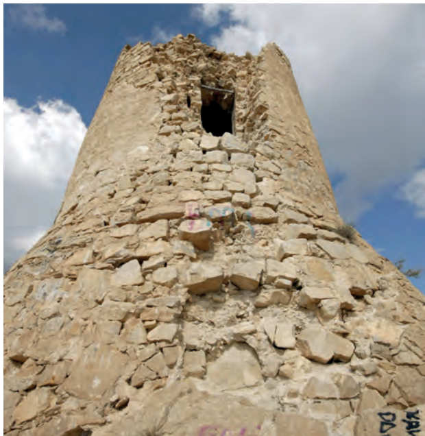
Figura 6.53: Vista panorámica de la torre desde su alambor donde se aprecia la impronta del acceso elevado.
