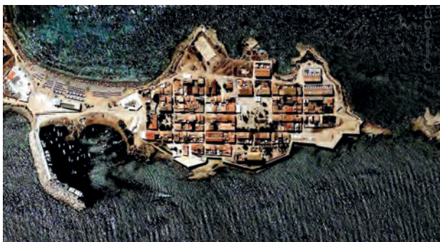
Figura 5.19: Vista aérea cenital de la isla de Nueva Tabarca y planta actual con los restos del recinto amurallado de la población. Ayuntamiento de Alicante.
