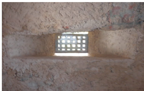
Figura 7.17: Vista interior de la cámara de tiro con deriva interna de la tronera de la Torre de Aquiló (La Vila Joiosa). Foto: Marius Beviá García.
