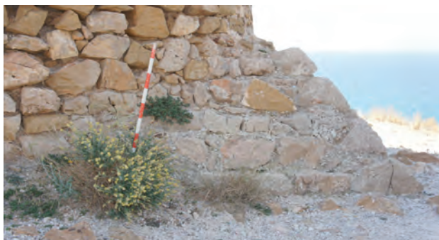
Figura 7.5: Esperonte de la Torre Caletes en Benidorm.
