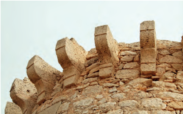
Figura 7.23: Ménsulas de la corsera que remataba la Torre Escaletes (Santa Pola).
