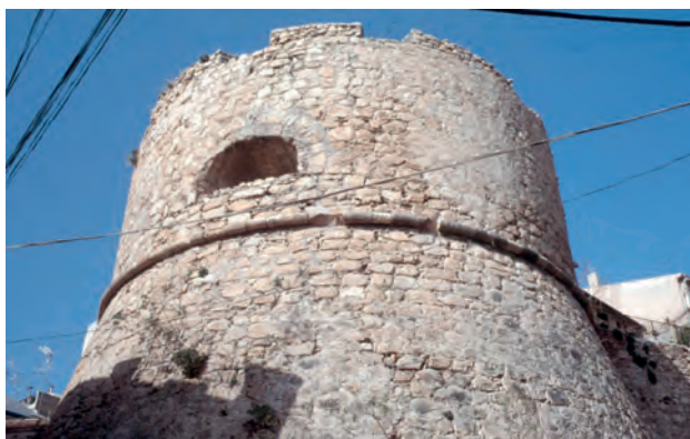
Figura 7.3: Alambor del impresionante cubo artillero de la fortificación de La Vila Joiosa.
