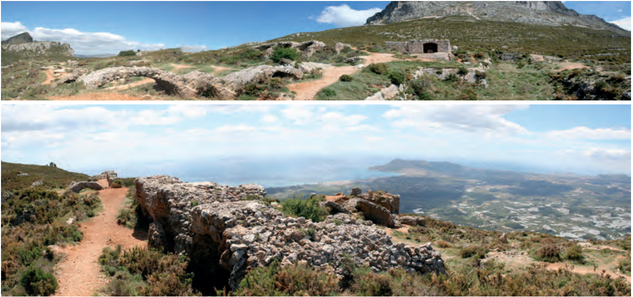
Figura 6.81: Vista panorámica de los restos del fortín desde el Sur. A la derecha, el canal del foso que aislaba la fortificación. Figura 6.82: Vista de los restos del fortín de Bernia desde el frente norte. Las arcadas corresponden al piso superior, desfondado sobre el semisótano en el derrumbe provocado en el año 1612.
