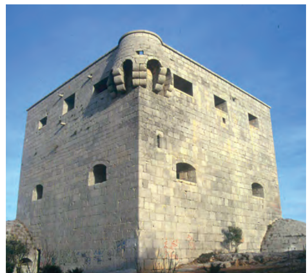
Figura 4.14: Vista general de la imponente Torre del Rey de Oropesa (Castellón).
