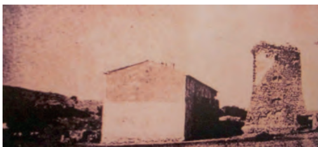
Figura 6.21: La Torre del Pinet en una imagen del inicios del siglo XX, cuando aún se encontraba en pie y en perfecto estado.
