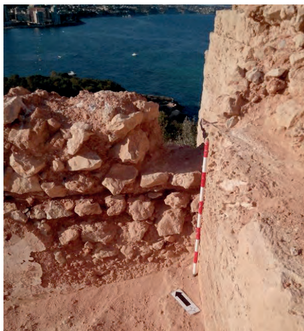
Figura 5.52: Aspillera de la muralla cegada parcialmente por la construcción de la torre campanario de la iglesia de Ifach. Archivo Gráfico MARQ.
