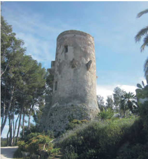
Figura 6.105: Vista general de la Torre del Cap Prim o del Portitxol situada en el jardín de una residencia particular. Foto: María Jesús Sánchez Mora.
