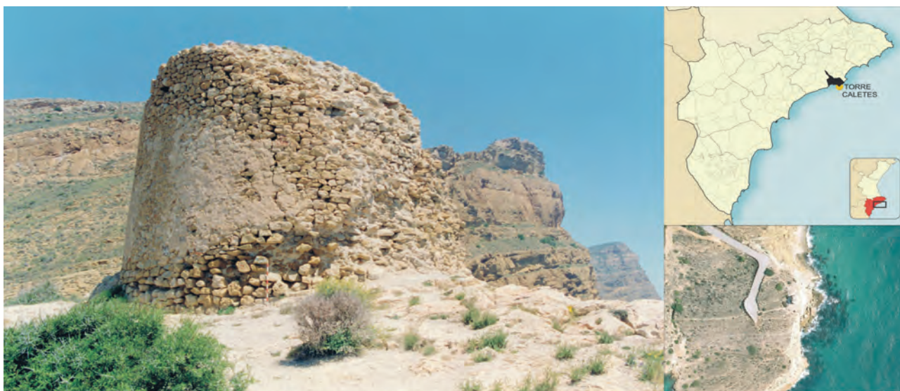
Figura 6.65: Localización y vista general de los restos de la Torre Caletes.
