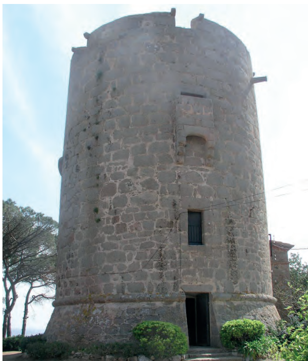
Figura 7.43: La Torre de Calella (Barcelona).
