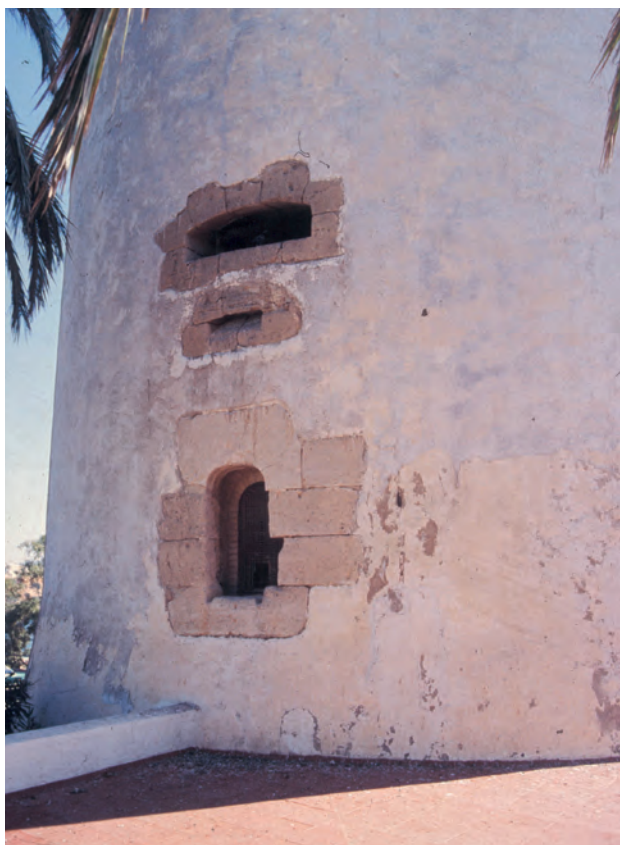
Figura 6.9: Vista del acceso elevado de la torre con la tronera y el buzón matafuegos defendiendo el acceso vertical al interior de la torre.
