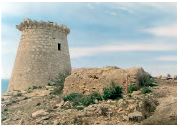
Figura 6.34: Vista de la torre Escaletes. En primer término, los restos del aljibe que abastecía a la torre de agua.
