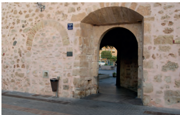
Figura 5.14: Acceso en codo de tradición medieval al interior del Castillo de Santa Pola.
