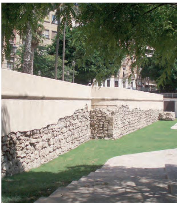
Figura 5.28: Restos de la muralla pre-abaluartada, ubicada en el actual Paseo Ramiro, construida por el Duque de Calabria en la primera mitad del siglo XVI.
