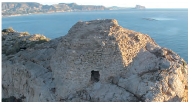
Figura 8.19: La Torre Bombarda en L'Alfàs del Pi después de su proceso de consolidación y restauración. Foto: Atrium Cultural Heritage Services.
