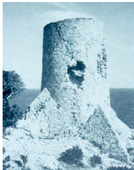
Figura 6.101: Vista general de los restos de la Torre Ambolo en una imagen de principios de siglo XX. Foto: Juan Mateo Box. Archivo AEAC.
