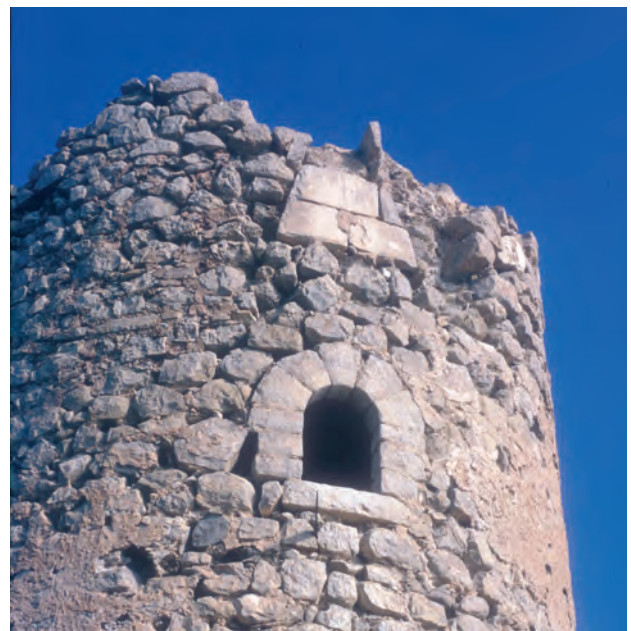
Figura 6.56: Detalle del acceso elevado al propugnáculo y del resto del tiro de la ladronera.
