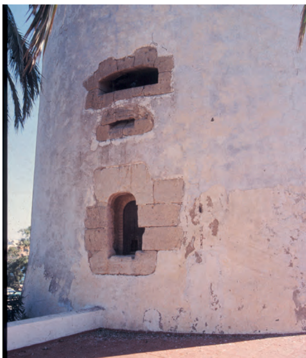
Figura 7.14: Buzón matafuego dominando el acceso a la Torre del Cap Roig (Orihuela).
