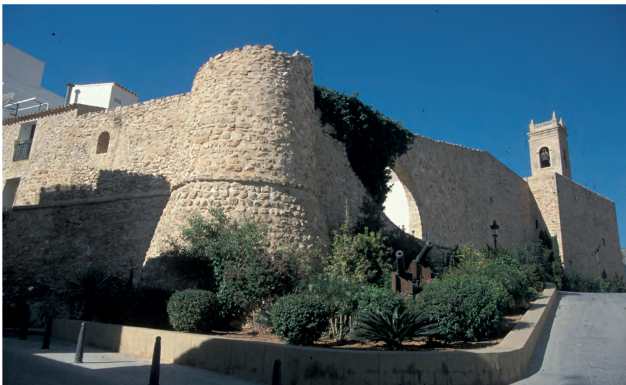
Figura 5.82: Vista actual de los restos del Torreón de la Peça, levantado durante la primera mitad del siglo XVI.
