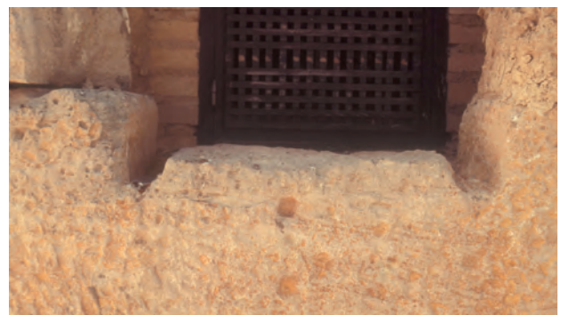
Figura 6.8: Detalle de las carriladas para disponer una escalera de cuerda que se encuentran en el vano del ingreso original de la Torre del Cap Roig. Foto: Francisco Javier Jover Maestre.
