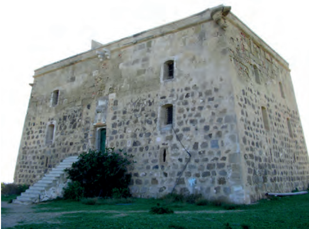
Figura 6.40: Fachada de la Torre de San José donde se encuentra el acceso elevado.
