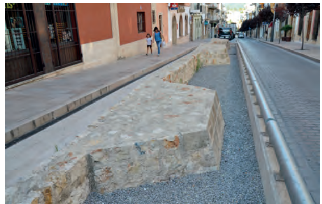
Figura 5.87: Tramo de la barbacana descubierto en las excavaciones de 2008 y conservado en la actual Avenida Príncipe de Asturias de Xàbia. Foto: Joanbanjo.
