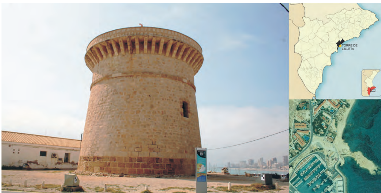
Figura 6.46: Localización y vista general de la Torre de la Illeta dels Banyets en el Campello con el coronamiento antonelliniano y la pasarela metálica exterior para acceder al interior de la defensa.
