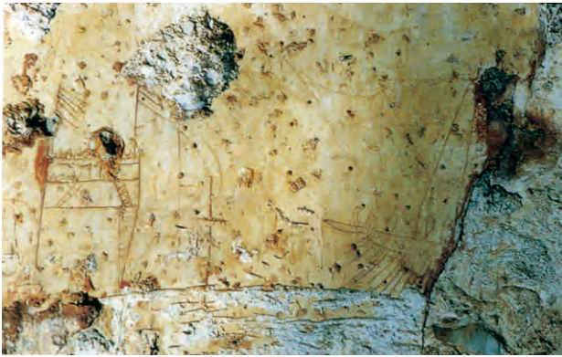
Figura 4.2: Graffiti en el que aparece una torre costera con doble hilada de almenas triangulares que hace señales a una galera en la Muralla Norte de la Alcazaba de Denia. Foto: Ayuntamiento de Denia.
