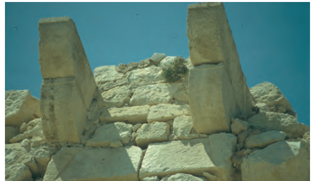
Figura 6.62: Detalle de las ménsulas de la ladronera que corona la torre.
