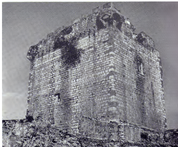
Figura 7.28: Vista de los restos de la Torre de La Carrova (Tarragona). Foto: Edward Cooper.
