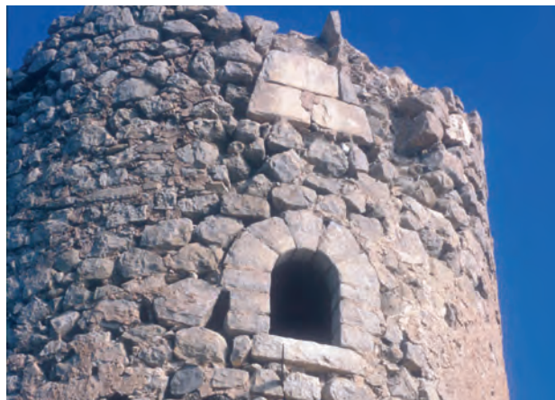
Figura 7.21: Detalle de los restos de las ladroneras de la Torre del Xarco (La Vila Joiosa).
