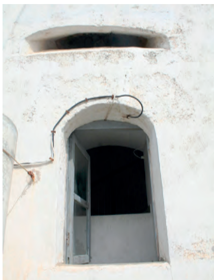
Figura 6.38: Acceso elevado con buzón matafuego situada en el frente este de la torre
