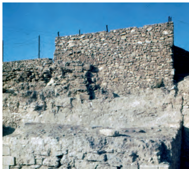
Figura 5.4: Detalle de la Torre de la Pólvora del Castillo de Guardamar durante las excavaciones en los años 80 del siglo XX. Archivo Gráfico MAG. Ayuntamiento de Guardamar del Segura.
