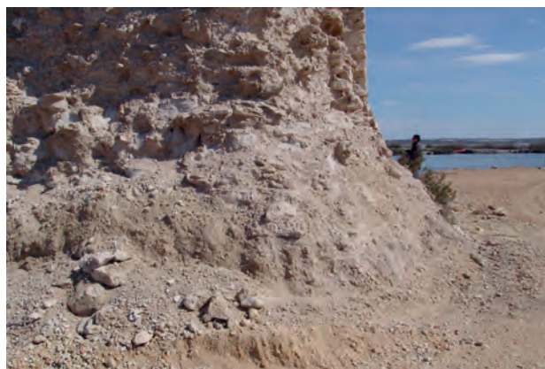
Figura 7.4: Restos del alambor de la Torre del Tamarit antes de su restauración. Foto: Marius Beviá García.
