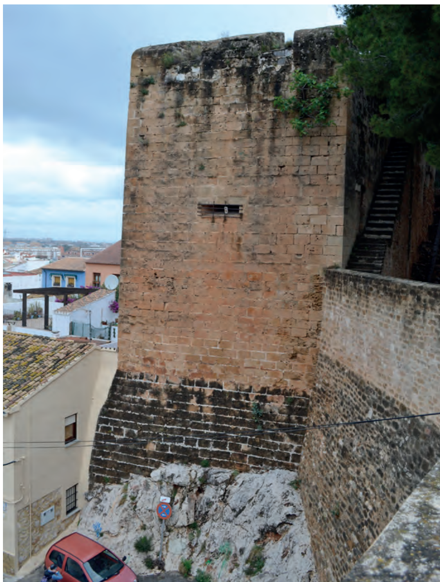
Figura 5.91: Vista exterior de la Torre del Consell de la Alcazaba de Denia.
