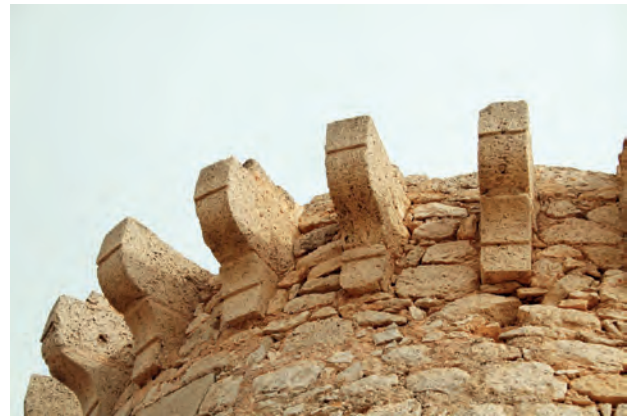
Figura 6.32: Detalle del coronamiento antonelliniano con la corsera corrida de la que se conservan las ménsulas.
