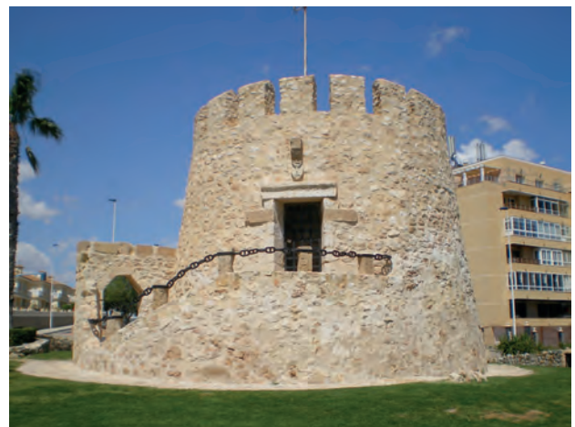
Figura 8.29: Vista general de la Torre del Moro de Torre Vieja después de su peculiar restauración. Foto: Oscar Lerma. Escuela Técnica Superior de Ingeniería de Edificación, Universitat Politècnica de Valencia.
