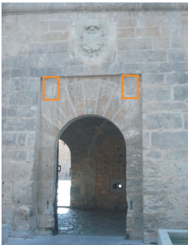
Figura 7.19: Detalle de la Puerta de ingreso al Fortín de Santa Pola. Arriba, aparecen marcadas las huellas del puente retráctil de la fortificación.
