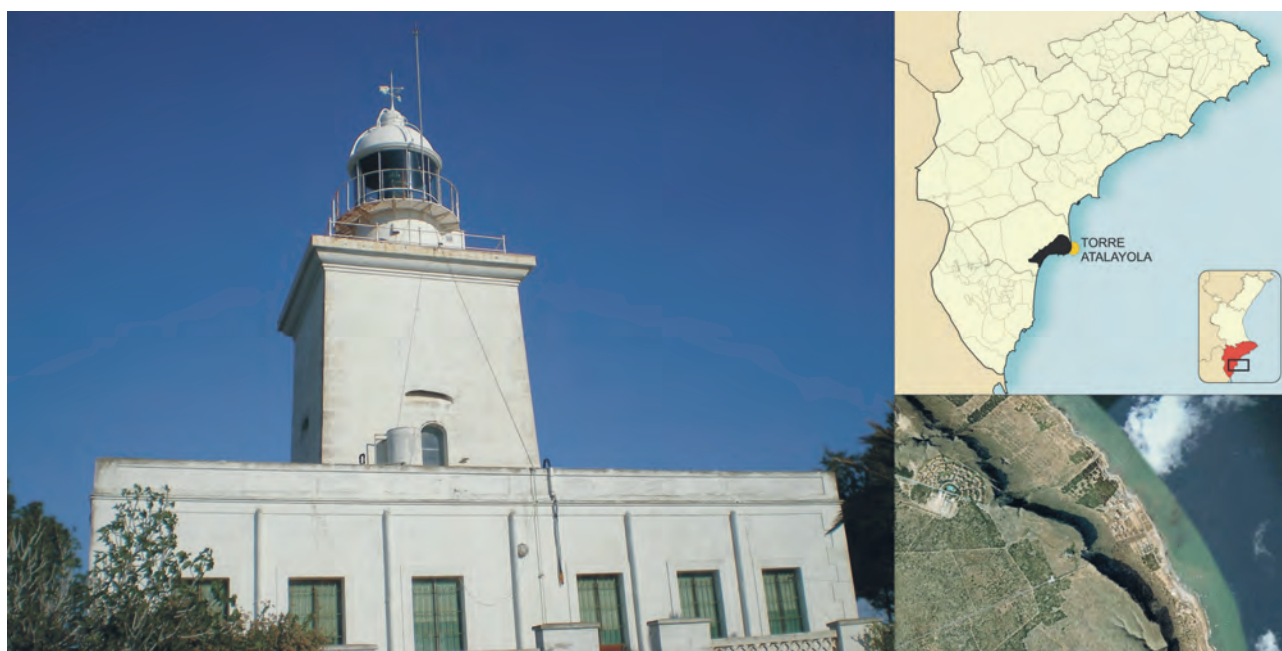
Figura 6.36: Localización y vista general actual de la Torre Atalayola reconvertida en Faro del Cabo de Santa Pola. Aún se observan las troneras de buzón dispuestas a media altura.
