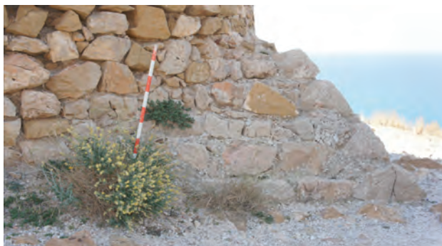
Figura 6.67: Detalle del esperonte situado en la base de la construcción.
