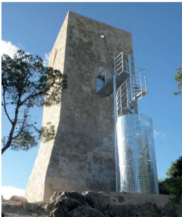
Figura 6.63: La Torre Aquiló en la actualidad con esa estructura metálica que permite el acceso al propugnáculo.
