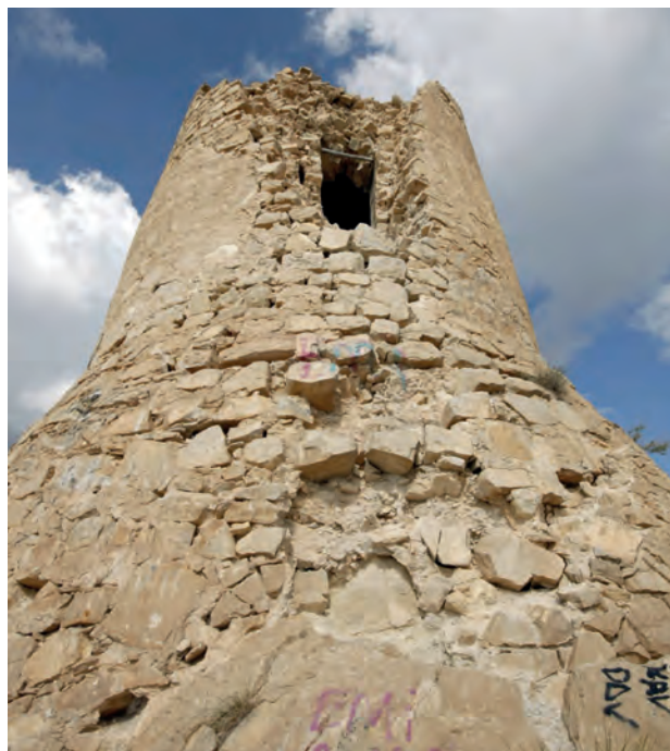
Figura 7.6: Acceso elevado a la Torre del Barranc d'Aigües.
