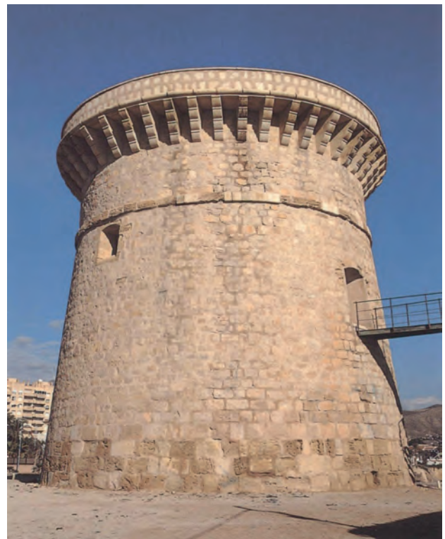
Figura 8.14: La Torre de la Illeta dels Banyets después de la restauración realizada en los años 80.
