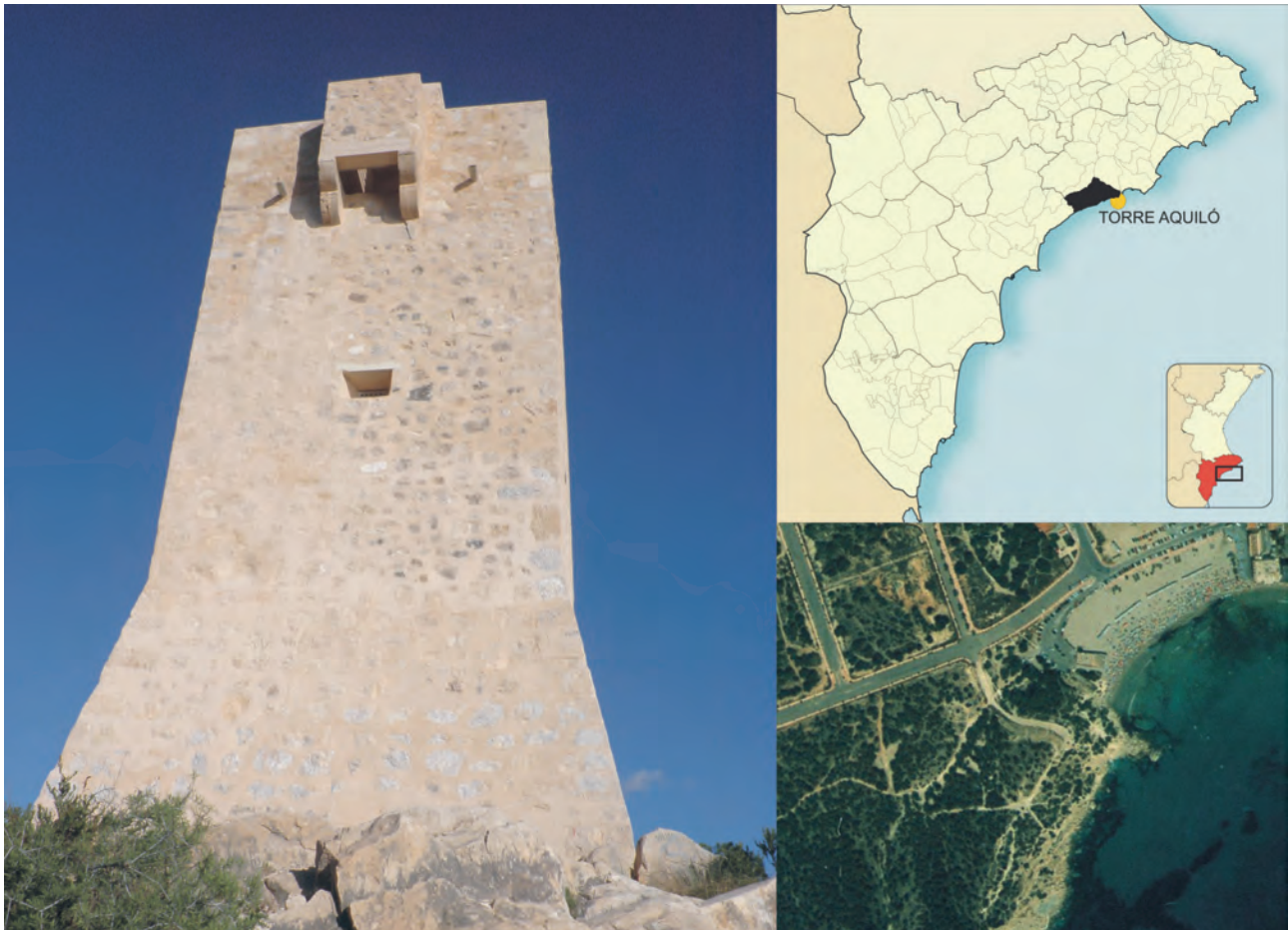
Figura 6.58: Localización y vista de la Torre Aquiló.
