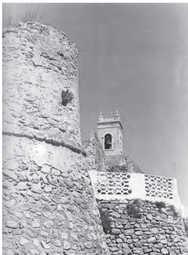
Figura 7.10: Bocel que separa el alambor en el Baluarte de la Peça en la muralla de Calp. Foto: Ayuntamiento de Calp.
