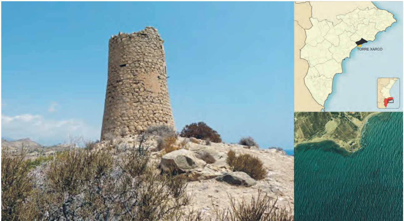
Figura 6.55: Localización y vista general de los restos de la Torre del Xarco.
