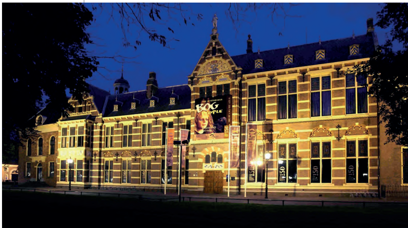
Fig. 1. Exterior del complejo del Drents Museum. El edificio de la izquierda es lo único que se mantiene del monasterio del siglo XIII.
