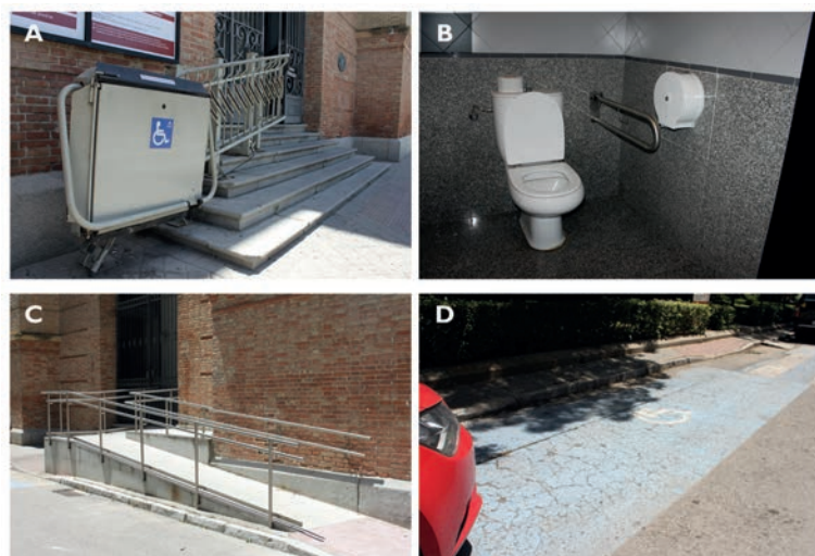
Figura 1. Actuaciones realizadas en el MNCN hasta la fecha. A) Tanto el ala norte como el ala sur del Museo Nacional de Ciencias Naturales (MNCN-CSIC) están dotados de una plataforma salvaescaleras de desplazamiento inclinado para facilitar el acceso al Museo de las personas con movilidad reducida (PMR). B) El MNCN dispone de baños accesibles para todo tipo de público, incluyendo las personas con movilidad reducida. Cuentan con barras de apoyo al lado del inodoro y la posición de los inodoros y los lavabos permiten que un usuario en silla de ruedas pueda efectuar un giro completo y acceder al inodoro por los dos lados. C) El MNCN está dotado de una rampa de acceso al ala norte que puede ser usada de una forma autónoma, cómoda y segura por parte de las PMR. D) Las PMR podrán aparcar sus vehículos en plazas específicas para discapacitados situadas en el interior del MNCN.
