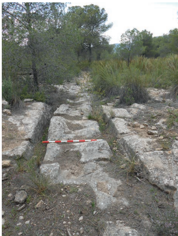
Figura 2. Tramo de carriladas en La Centenera.
