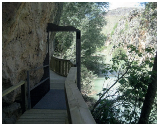
Figura 2. Pasarela de madera que lleva a las pinturas rupestres "Los Abrigos del Pozo"
