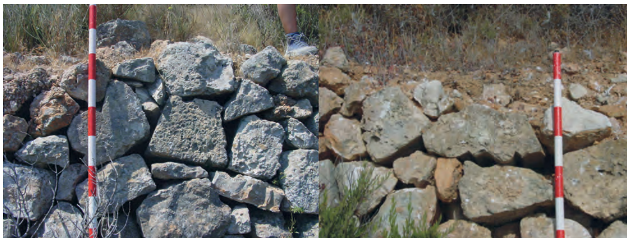
Figura 5: Localización de sillería procedente de los edificios de la pobla que se encuentra integrada en los bancales de la ladera del Peñón. Archivo Gráfico MARQ.
