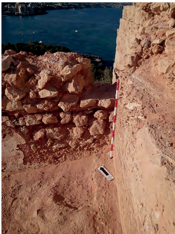
Figura 10: Restos de una aspillera con deriva interna en la muralla norte de la pobla, actualmente inutilizada por la construcción de la torre campanario de la iglesia de Ifach. Archivo Gráfico MARQ.
