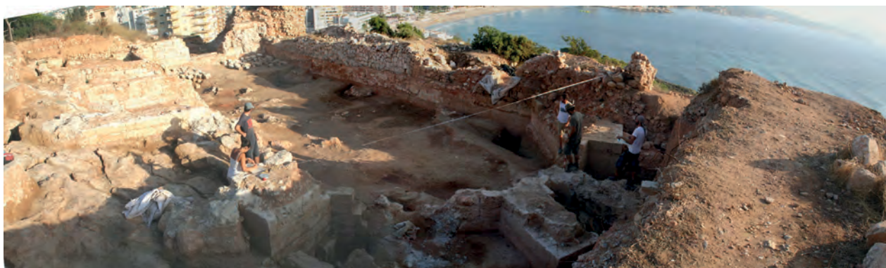
Figura 16: Trabajos de documentación planimétrica en el ábside de la iglesia de Ifach. Archivo Gráfico MARQ.
