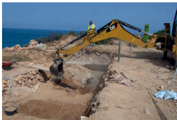
Figura 20: Retirada mecánica de los restos del Hotel Palace Ifach que se hallaban dentro de la estructura de la iglesia. Archivo Gráfico MARQ.
