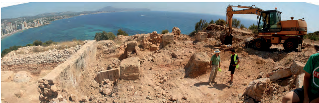
Figura 12: Vista panorámica de los trabajos de retirada mecánica de los pilares de hormigón del hotel Palace Ifach que invadían el interior de la nave central de la iglesia. Archivo Gráfico MARQ.
