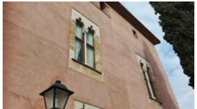
Figura nº 106: Detalle de los ventanales del tipo coronella dotados con capiteles de palmas y roseta central de la fachada del Palau del Comte en Faura, Camp de Morvedre, Valencia.
