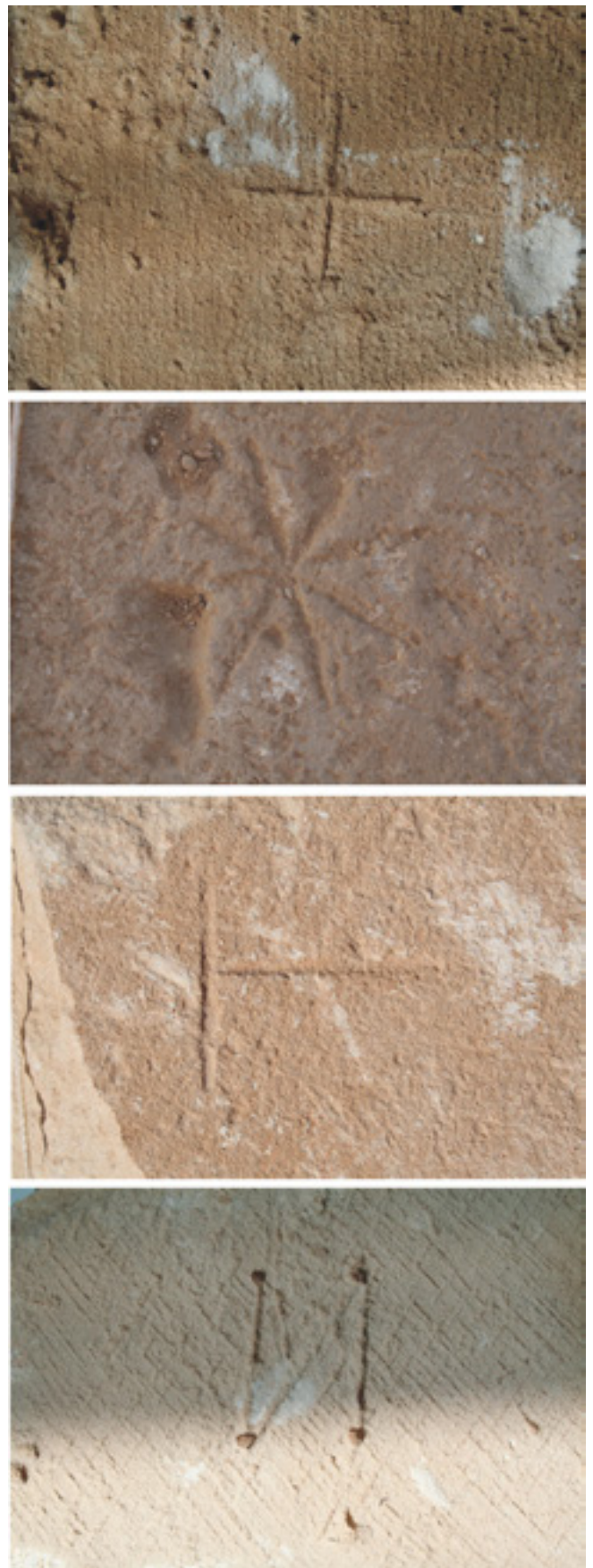
Figura nº 56: Algunas de las marcas de cantero documentadas en diferentes sillares de la pobla de Ifach. Archivo Gráfico MARQ.
