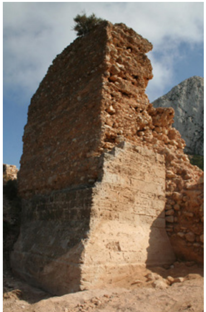
Figura nº 4: Restos de la monumental torre campanario de la iglesia medieval de Ifach. Archivo Gráfico MARQ.
