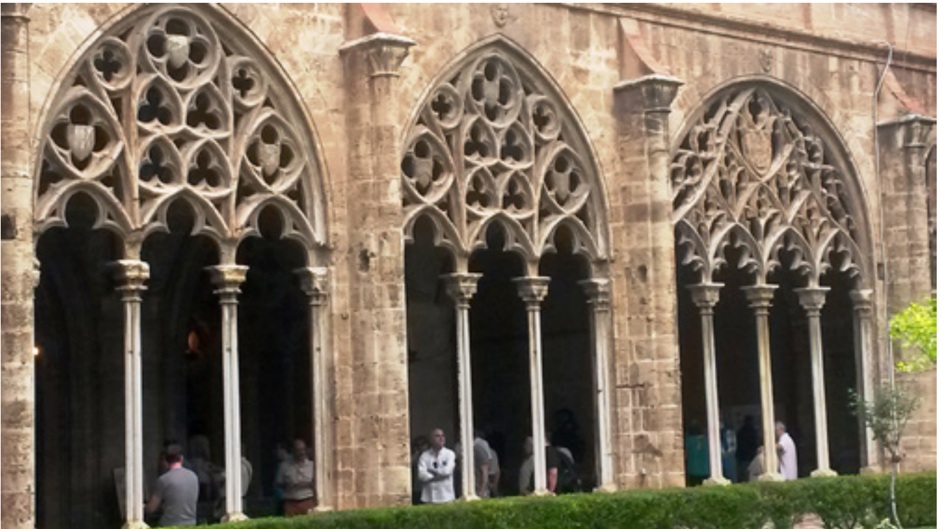
Figura nº 97: Detalle del Claustro del Convento de Sant Domènec en la ciudad de Valencia donde se encuentran numerosos ejemplares del capitel de palmas y roseta central. Imagen: Cortesía de Pilar Mas Hurtuna.
