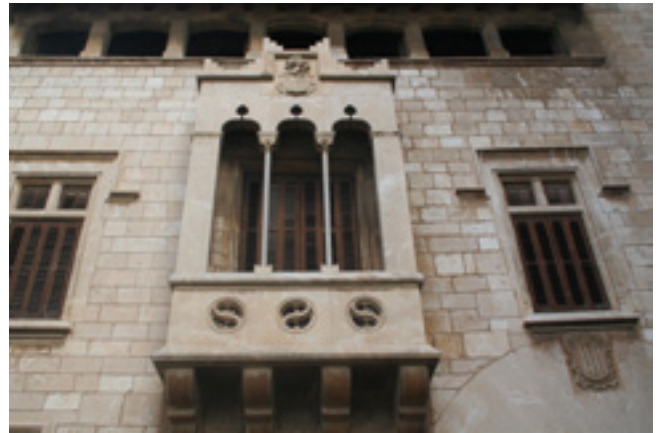
Figura nº 86: Detalle de la balconada con el ventanal del tipo coronella en la fachada del Palau Babau o Baltà en Vilafranca de Penedés, l'Alt Penedés, Barcelona.
