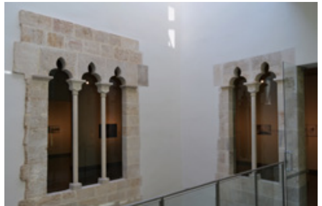
Figura nº 92: Capiteles de imitación gótica instalados en la restauración del Palau Catalá de Valeriola en la ciudad de Valencia, sede actual de la Fundación Chirivella Soriano.
