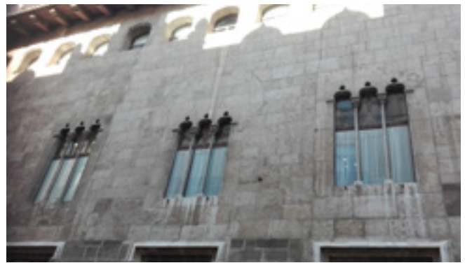
Figura nº 95: Fachada recayente a la calle Cavallers del Palau de la Generalitat, donde se encuentran varios ventanales del tipo coronella con capiteles de palmas.
