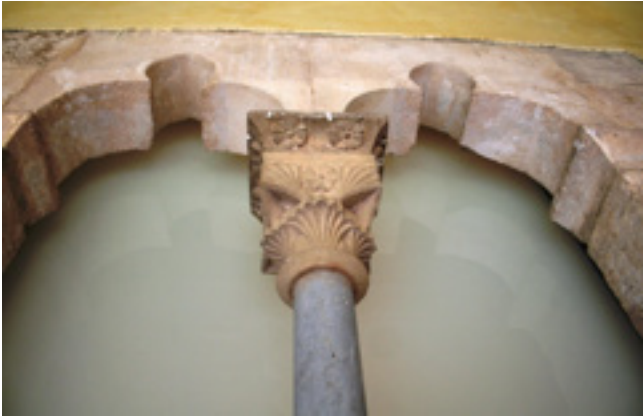
Figura nº 70: Detalle del capitel del ventanal del tipo coronella en la segunda planta del deambulatorio del claustro del Monasterio de Santa María de Pedralbes en Barcelona.
