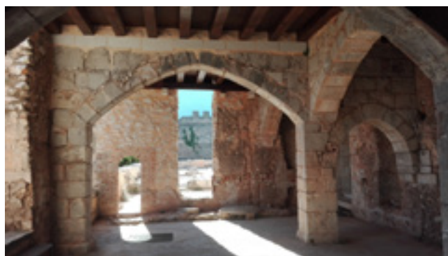
Figura nº 122: Arco diafragmático rebajado de la planta baja del Palacio del Abad en el Monasterio de Santa María de La Valldigna, Valencia.
