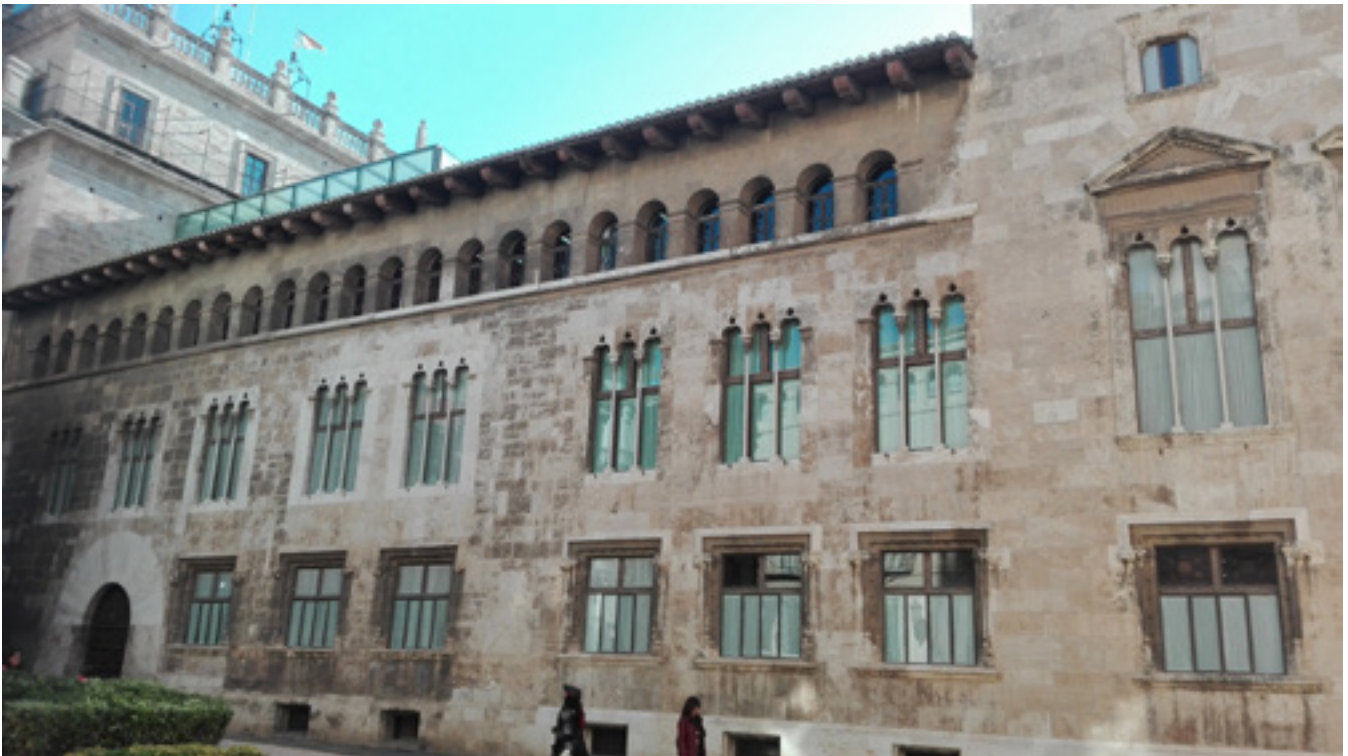
Figura nº 93: Fachada recayente a la calle Batllia del Palau de la Generalitat, donde se encuentran varios ventanales del tipo coronella con capiteles de palmas.
