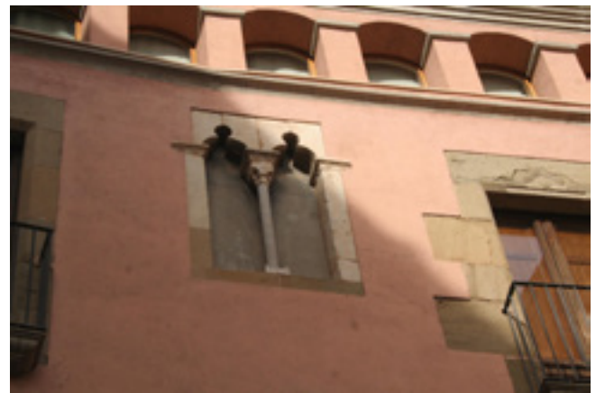
Figura nº 82: Detalle del ventanal tipo coronella con el capitel de palmas y roseta central en la fachada de la segunda planta de la Casa Bayés, en la ciudad de Vic, Osona, Barcelona.
