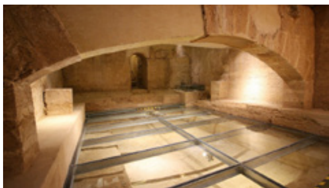
Figura nº 123: Arco rebajado de la bodega gótica de la Plaza de la Ploma en la ciudad de Valencia. Siglo XIV.
