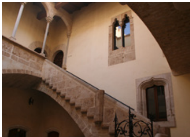
Figura nº 108: Ventanal del tipo coronella con el capitel de palmas y roseta central en el patio interior del Castell-Palau de Albalat dels Sorells, Horta Nord, Valencia.
