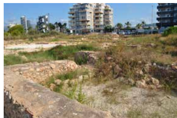
Fig. 6.22. Crecimiento descontrolado de vegetación sobre la Noria, Vivienda 2 y Molí del Morelló
