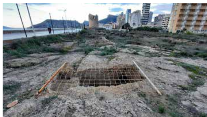
Fig. 5.26. Sistema improvisado de la cubierta del acceso a la Noria
