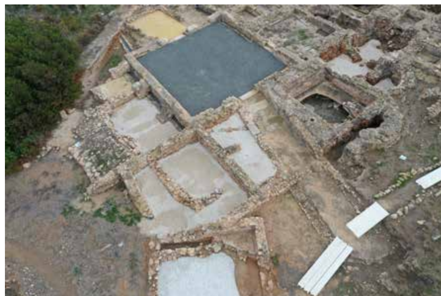
Fig. 5.107. Cubierta con geotextil y gravas diferenciadas en las Termas Orientales (Alebus, 2020)
