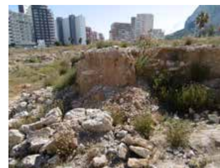
Fig. 5.83. Derrumbes por pérdida de soporte
