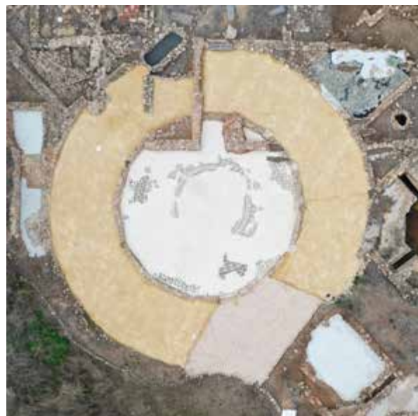
Fig. 5.29. Patio circular. Estado que presentaba la Domus rotunda a la finalización de los trabajos de mantenimiento (Alebus, 2020)
