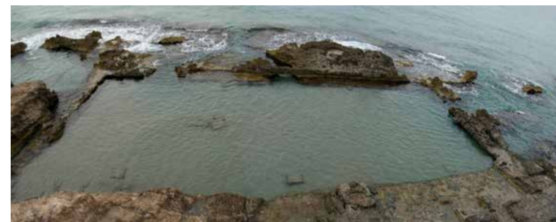
Fig. 6.6. Vista de los Viveros colmatados por aportes de arenas que ocultan las estructuras internas. Año 2009
