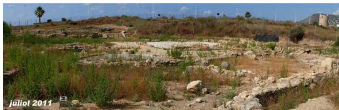
Fig. 5.1. Vivienda 1 o Domus rotunda . Proceso de deterioro alcanzado sin un mantenimiento continuado
