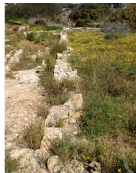
Fig. 5.55. Vista de la línea de muro dotada de contrafuertes
