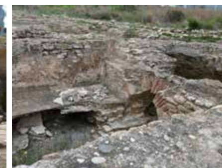
Fig. 5.84. Rotura e inestabilidad estructural
