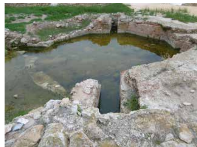
Fig. 5.71. Humedad y acumulación de líquido por filtraciones freáticas y escorrentías de agua de lluvia
