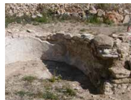
Fig. 5.80. Formación de eflorescencias en superficie de revestimientos
