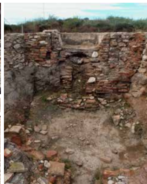
Fig. 2.121. Caldarium con pérdida de la suspensura que sustentaba el suelo originario. Al fondo bañera sobre la boca del praefurnium
