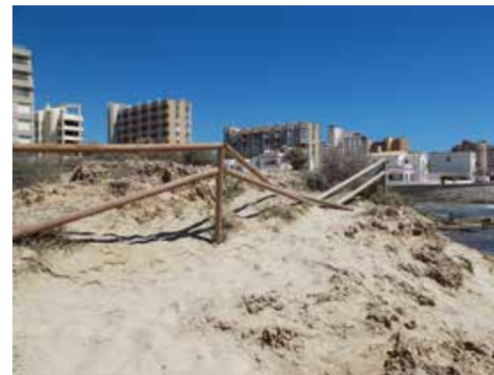
Fig. 5.4. Imagen del estado actual del vallado perimetral
