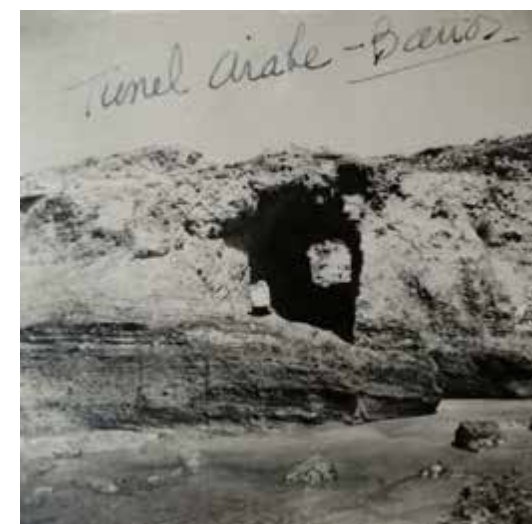
Fig. 6.8. Galería túnel Banys, año 1970 (foto cedida por J. Vázquez)
