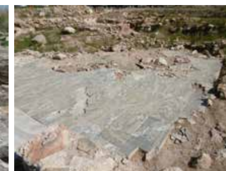
Fig. 5.85. Deformación por hundimiento en asiento diferencial
