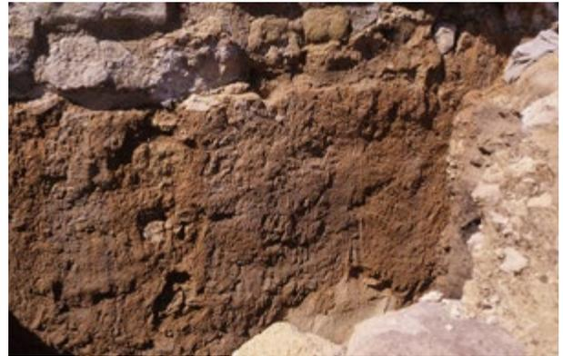
Fig. VI.21. Enfoscado de la muralla. Lienzo entre torre Va y VI del tramo 5. ATM.
