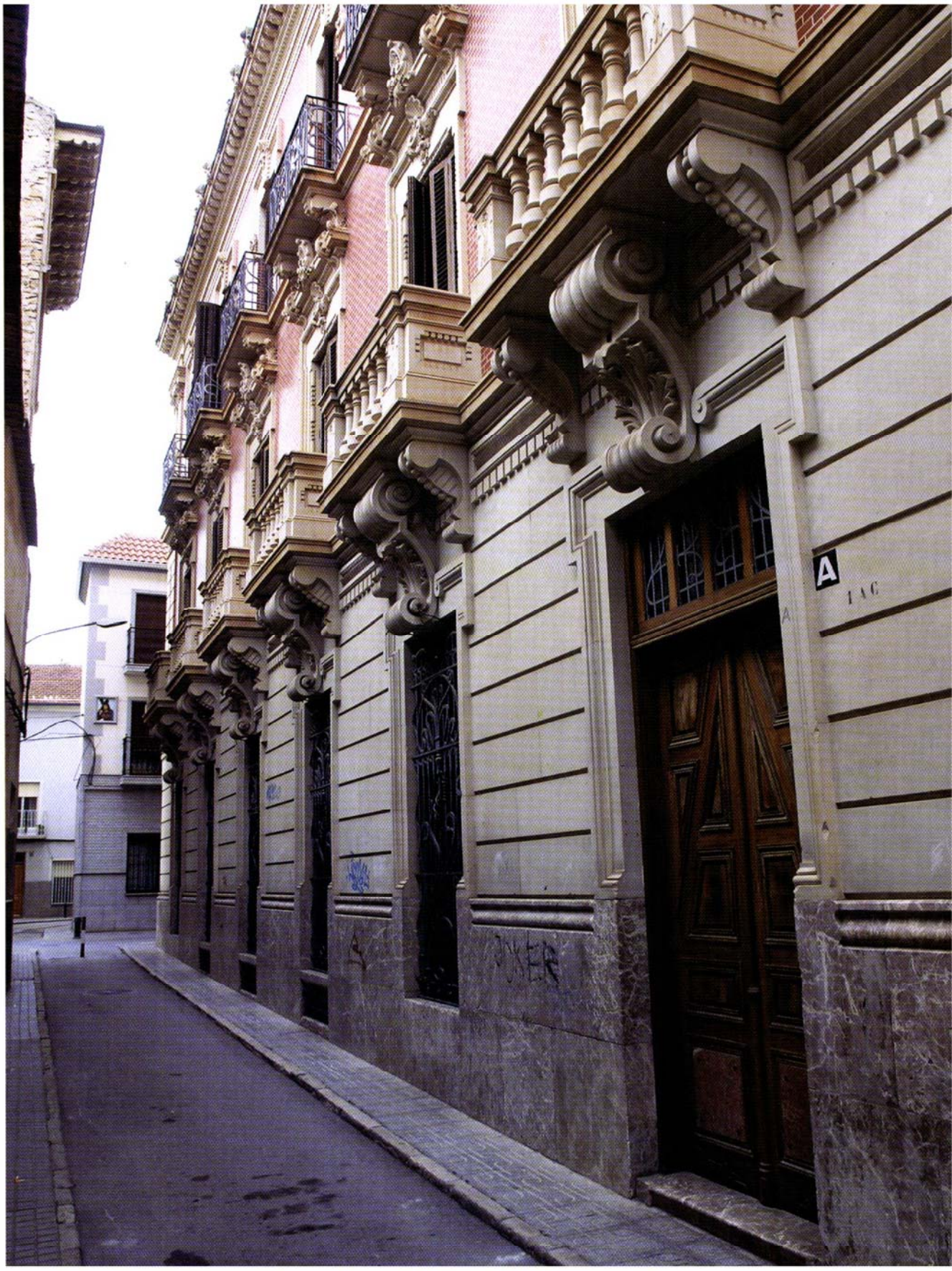
Fachada de la Casa Museo Modernista de Novelda
