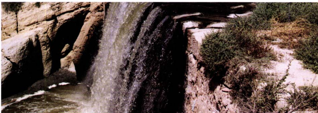
Vista general de El Azud de Novelda
