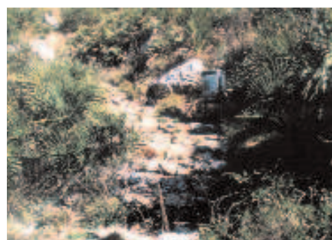
Escalera y papelera de mantenimiento
