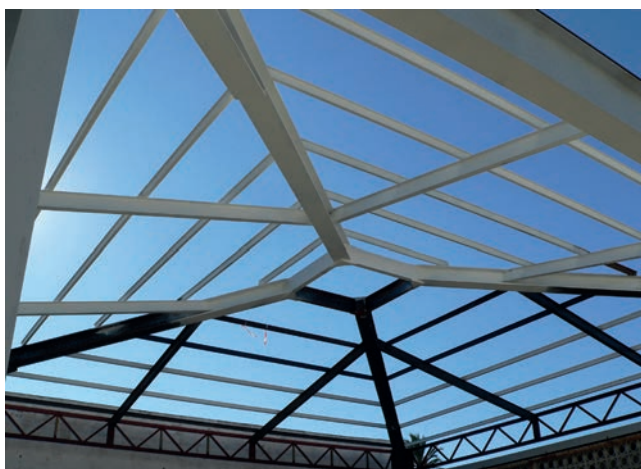
Figura 7. Estructura metálica que soporta la cubierta de la Sala Hispania del Museo Monográfico de La Alcudia.
