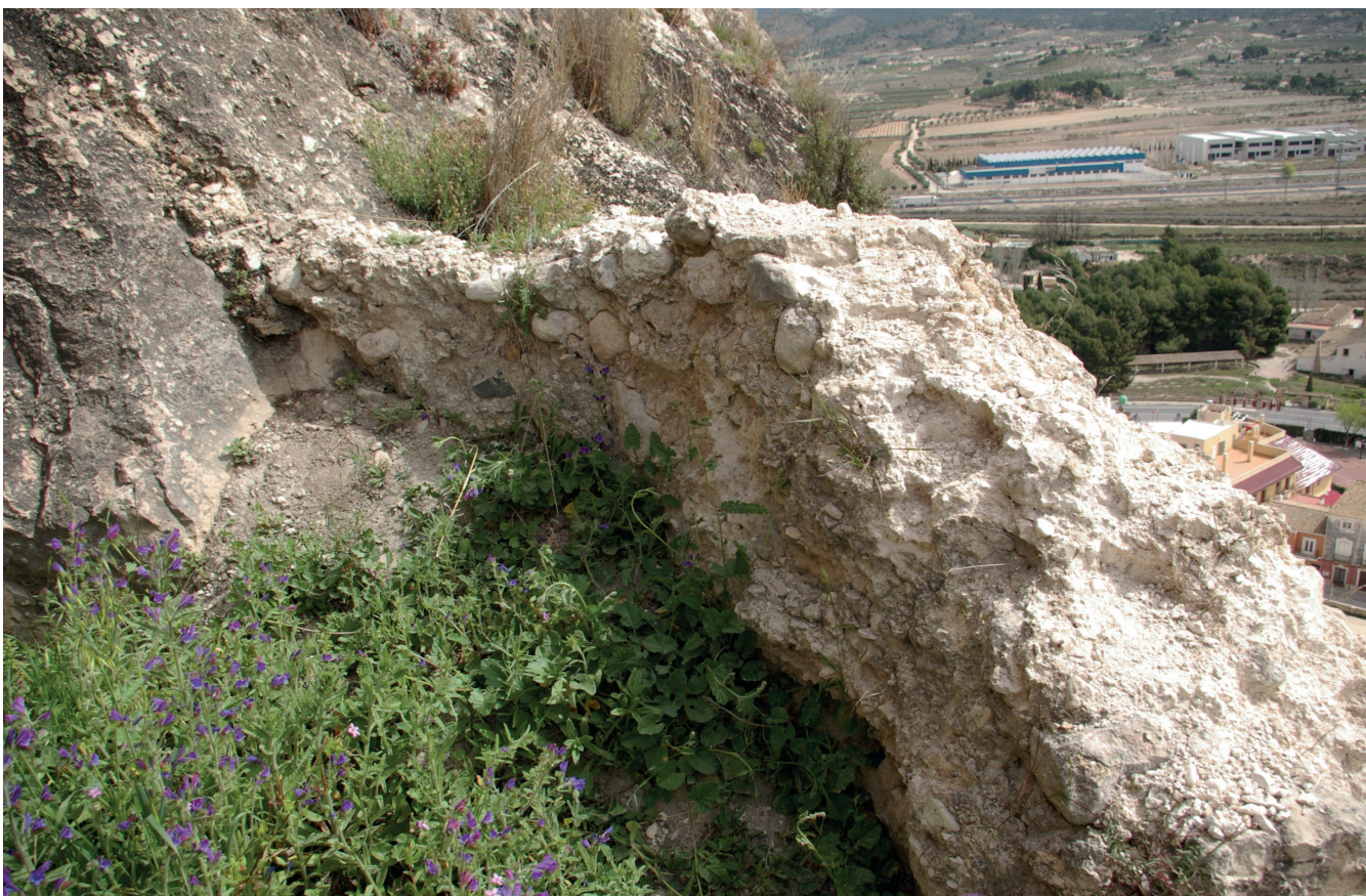
Figura 4. Mur de tancament de la cubeta al vessant sud
