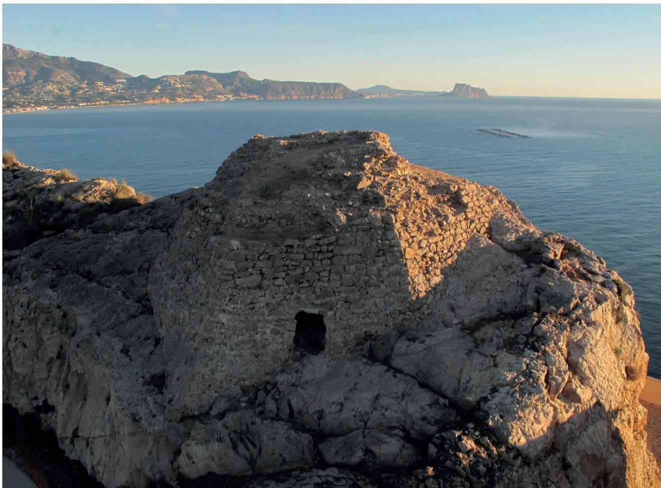
Figura 2. Vista general de la torre durante el proceso de excavación. El vano abierto en su cara norte corresponde a una actuación realizada en el siglo XIX por los fareros para reaprovechar la estructura. En el proceso de restauración de la torre este vano fue tapiado.
