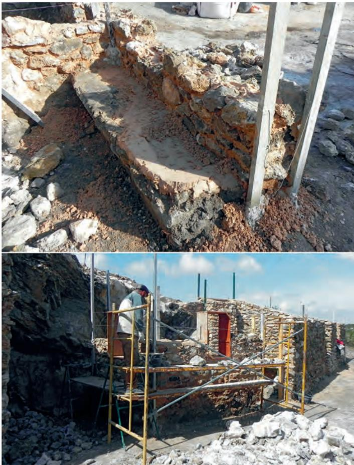
Figura 15. Proceso de rehabilitación de los muros de los almacenes del complejo yesero, donde hemos utilizado mortero de cal con arena para unir la mampostería, con posterioridad el rejuntado se realizará con yeso preparado con ceniza y grava del lugar.
