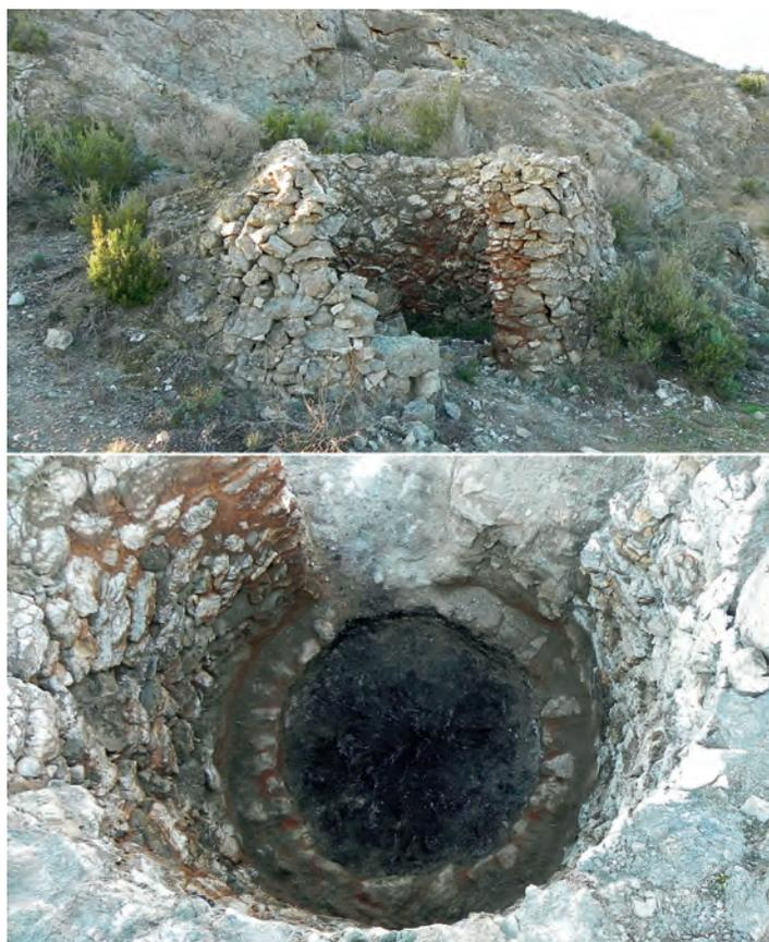
Figura 14. Horno pequeño localizado al este del conjunto de hornos de yeso del Cabezo del Sastre, construcción posiblemente algo más antigua, que una vez excavada nos permitió recuperar el área de combustión con restos de ceniza y su peldaño lateral.
