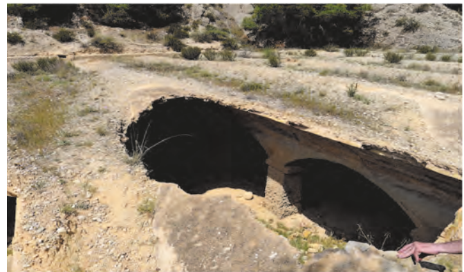
Figura 23: Vista desde el vaso seco del Azud de la Tanca del Forat. En la ribera oriental se observa en primer término la plataforma de un molino andalusí, luego un pequeño acueducto que conducía la Séquia Major. En la ribera occidental, se destacan los sillares de uno de los estribos del azud, la acequia andalusí y otra superpuesta pintada a la almagra datada a mediados del siglo XVIII. Al fondo El Pont dels Moros.
