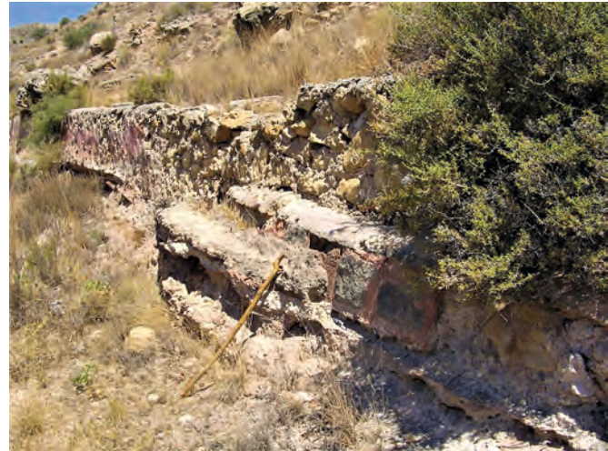
Figura 19: Acequia inferior andalusí reformada con ladrillos en el siglo XVII. Una nueva acequia se le superpuso en determinados tramos, como en este ejemplo en el entorno del paraje de La Séquia Fonda.
