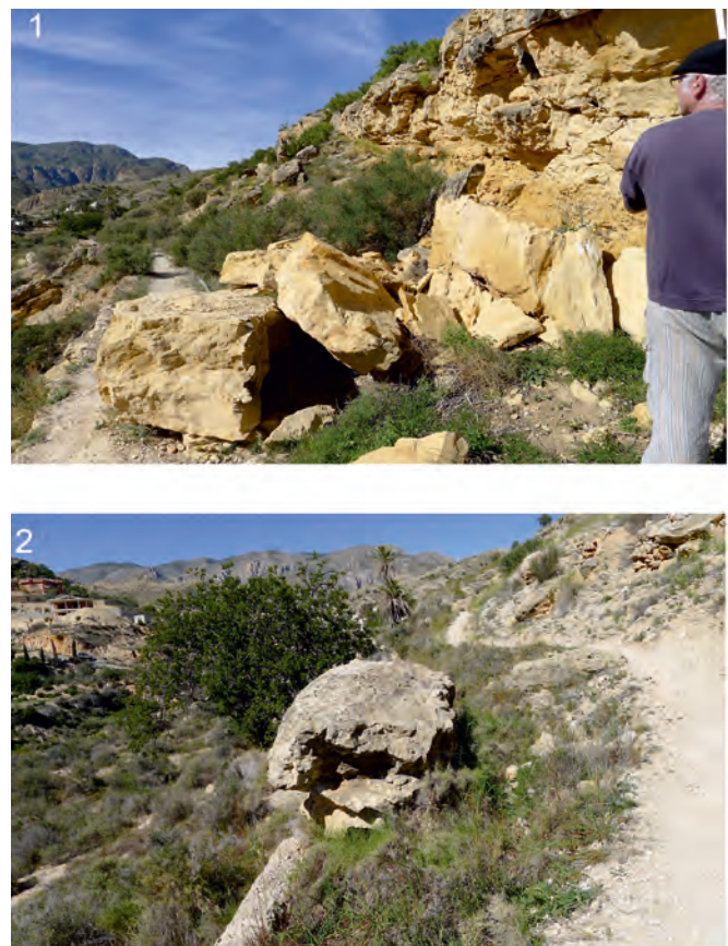
Figura 14: Nº 1. Desprendimiento rocoso cubriendo la acequia del siglo XIX en el paraje de la Séquia Fonda, tras unas lluvias torrenciales en 2016. Nº 2: Desprendimiento antiguo sobre la acequia del siglo XVIII.
