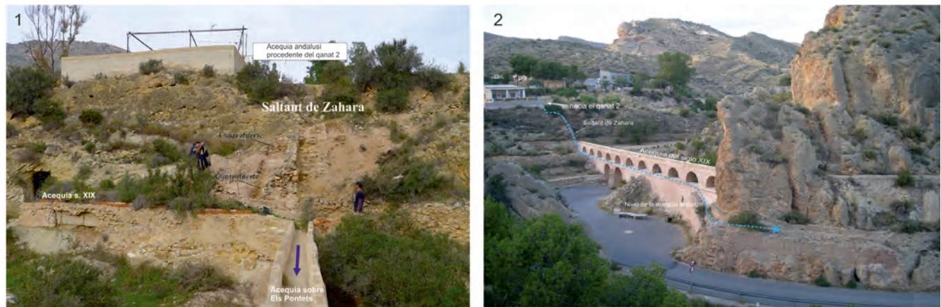
Figura 12: Nº 1. Vista del Saltant de Zahara, conectado a la acequia andalusí que discurre por un nivel superior. Nº 2. El Saltant de Zahara con indicación del recorrido de la acequia andalusí procedente del qanat 2.
