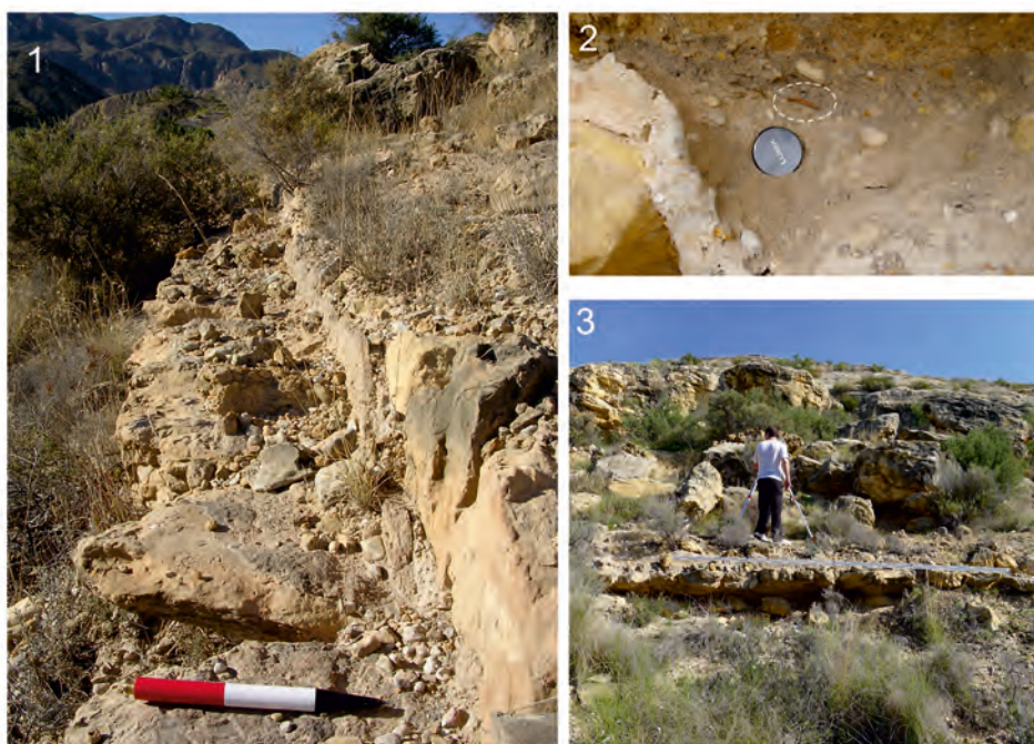
Figura 16: Nº 1. Acequia paleoandalusí. Nº 2. Detalle de la cerámica emiral incrustada en sus cimientos descalzados antes de ser retirada. Nº 3. Vista de la base de la acequia descalzada.
