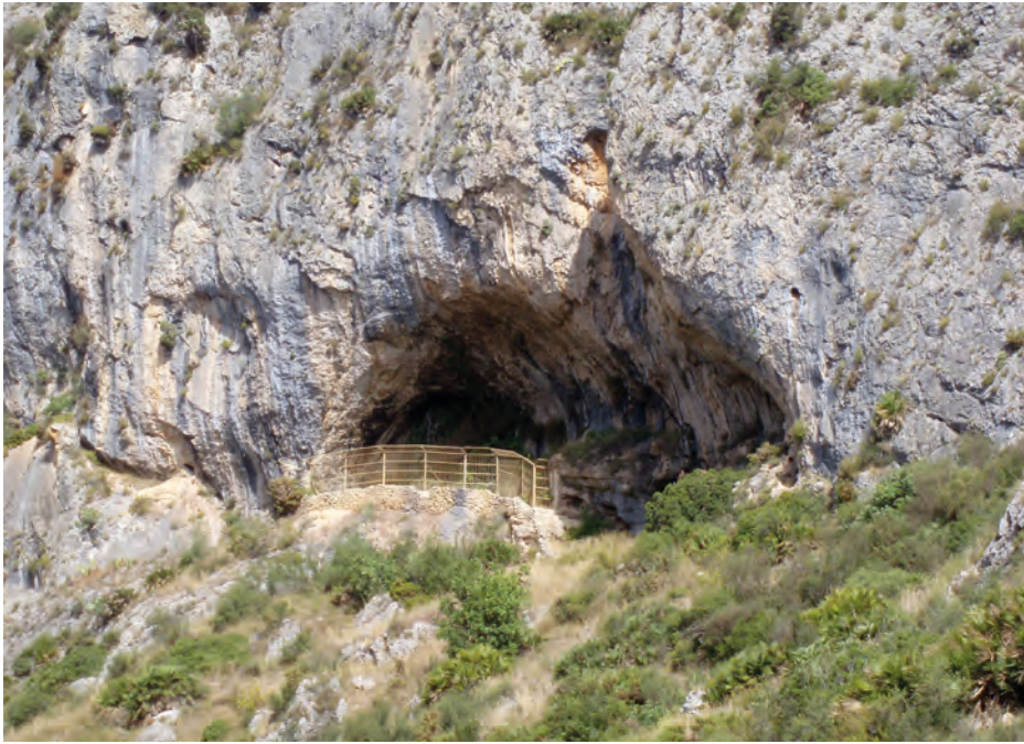
Figura 1. Les Torrudanes (La Vall d'Ebo). Vista general del cerramiento con estructura de piedra en seco como base y con estructura metálica en la parte superior de esa base. Fotografía J.A.López.
