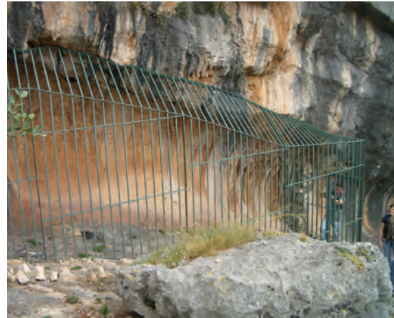
Figura 3. Barranc de Benialí. Abric IV (Vall de Gallinera). Nuevo cerramiento metálico. Fotografía J.A.López.
