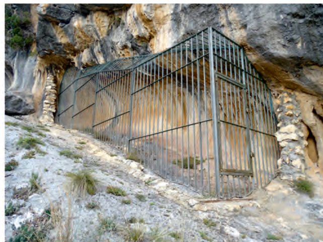
Figura 15. Mojeras del vallado de Beniali con la retirada de los restos de muro de mampuestos del vallado de 1986.
