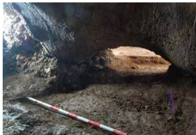
Figura 3. Detalle del acceso II, una vez excavados los sedimentos desde la Galería A a la galería B.
