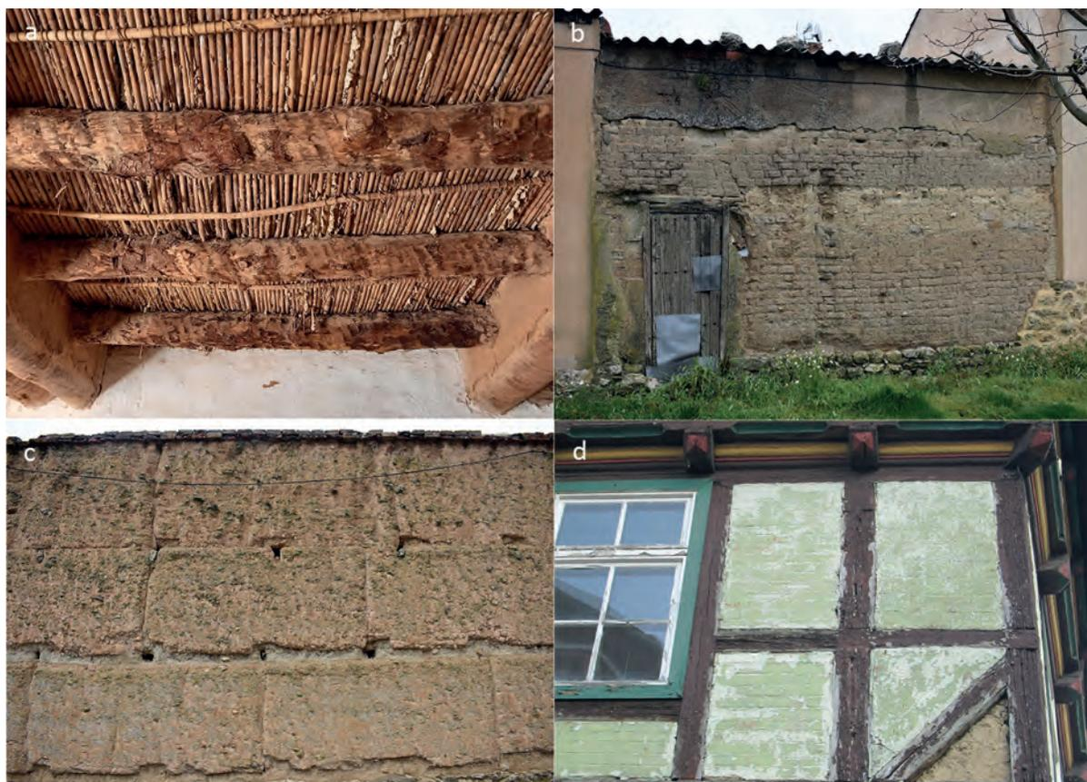
Figura 1. Distintas técnicas constructivas con tierra. a. Bajareque, con cañas paralelas, sujetas con cañas guía y cubiertas de barro en el interior de una techumbre en el yacimiento y centro de arqueología experimental de la Ciudadela ibérica de Calafell (Tarragona). b. Adobe, y c. Tapial, en dos muros de Urueña (Valladolid). d. Entramado, con paneles de madera rellenos de tierra en Quedlinburg (Sajonia-Anhalt, Alemania).
