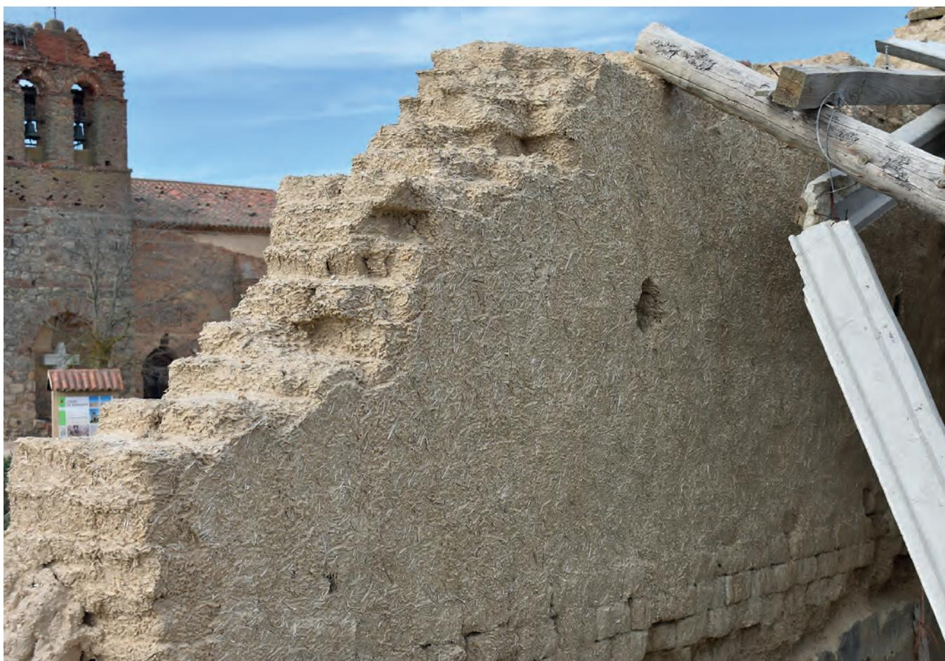
Figura 8. Revestimiento de barro y materia vegetal en un muro de adobe todavía en pie, en una construcción abandonada en Otero de Sareigos (Villafáfila, Zamora).
