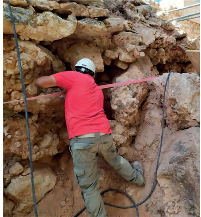
Figura 3. Detalle del inyectado para consolidar la sillería de la portada de la Iglesia de Beata Santa María de Ifach. Archivo Gráfico MARQ - Área de Arquitectura de la Diputación de Alicante.
