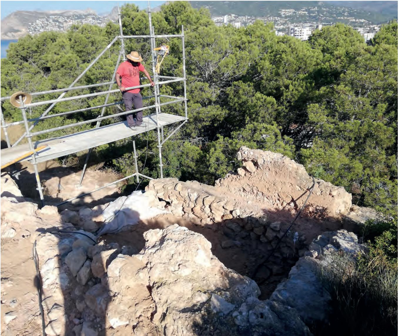
Figura 5. Detalle de los trabajos de consolidación de la base de la Torre 2 de la muralla de la Pobla de Ifach (Archivo Gráfico MARQ).
