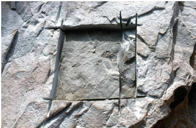
Figura 3. Benirrama I. El autor del saqueo realizó con extraordinaria pericia la extracción de la roca.
