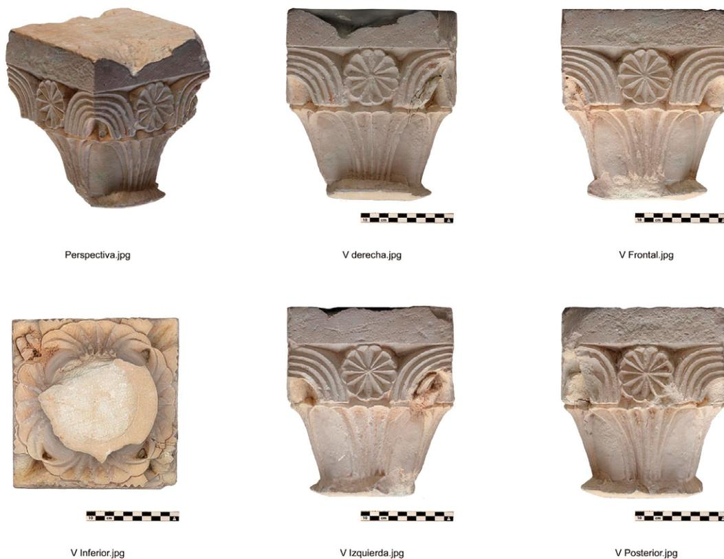
Figura 26. Perspectiva, vista inferior y vistas frontales del capitel gótico de uno de los ventanales *ab corves* de la planta superior del Edificio 6 de Ifach. Ortofotos: Pilar Mas Hurtuna. Archivo Documental Técnico MARQ.
