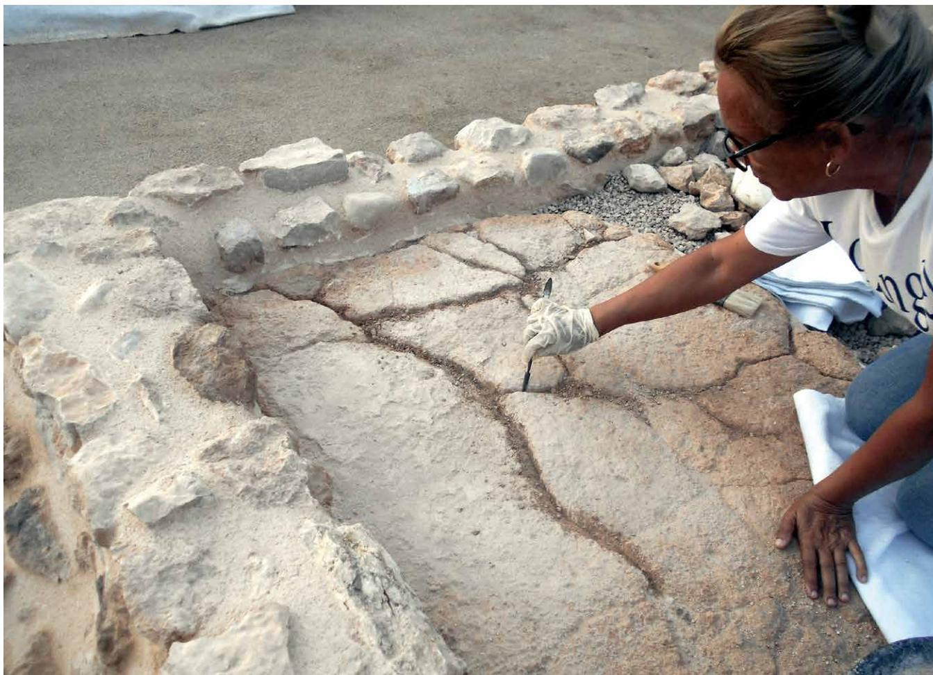
Figura 5.- Detalle del proceso de consolidación de las superficies realizadas con mortero de cal.
