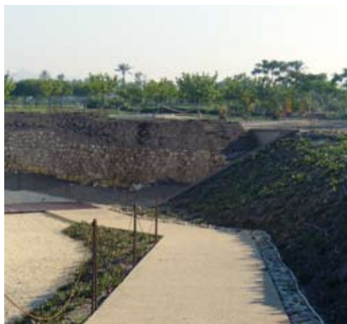
Vista de la muralla de La Alcudia tras su consolidación y restauración.
