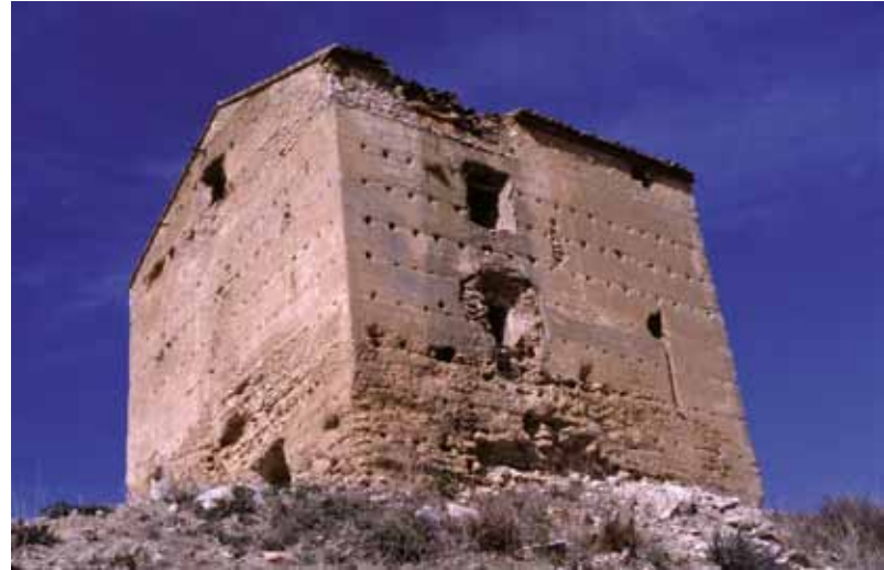
Figura 8. Torre de Torremanzanas (Foto R. Azuar)
