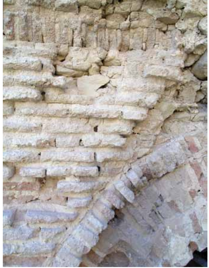
Figura 11. Detalle del arco y alfiz exterior del vano Oeste de la Torre de Sant Jordi.
