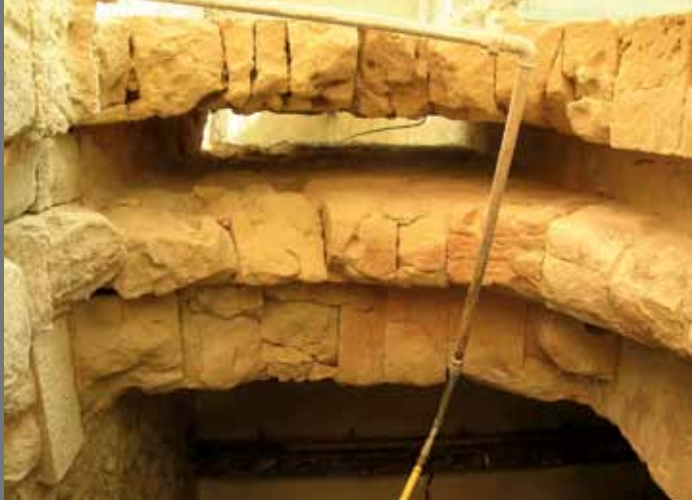
Figura 15. Detalle de los ejes verticales y hueco horizontal por los que se deslizaba e izaba respectivamente el rastrillo.
