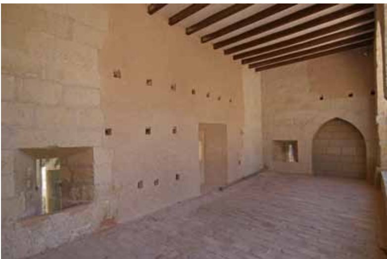
Figura 34. Vista interior del nivel intermedio de la Torre de Santa Caterina, después de la restauración.
