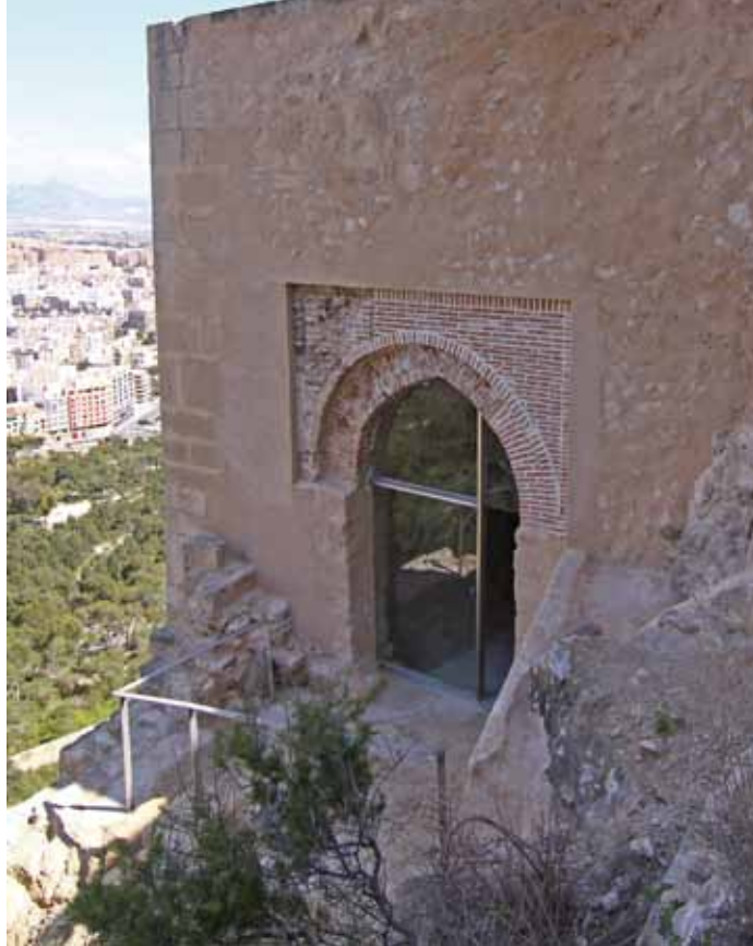
Figura 29. Vista del arco con alfiz, en el alzado exterior Oeste de la Torre de Sant Jordi.
