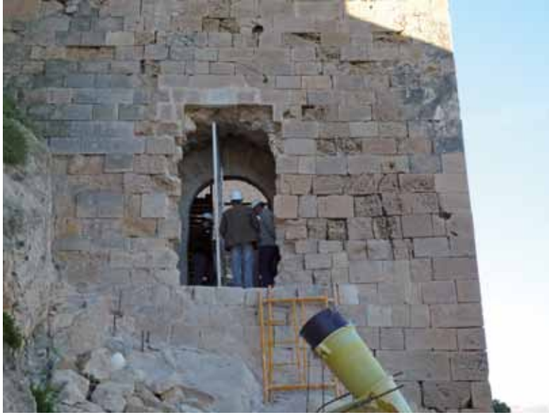
Figura 23. Detalle del alzado Este de la Torre de Sant Jordi, donde se puede observar la nueva abertura, con el arco de la puerta en un segundo plano.
