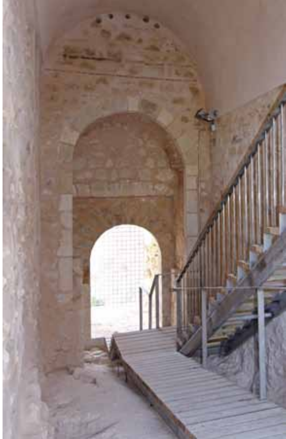
Figura 28. Vista interior de la Torre de Sant Jordi. Al fondo aparece el complejo sistema de puertas. Las pasarelas permiten el acceso a la sala.
