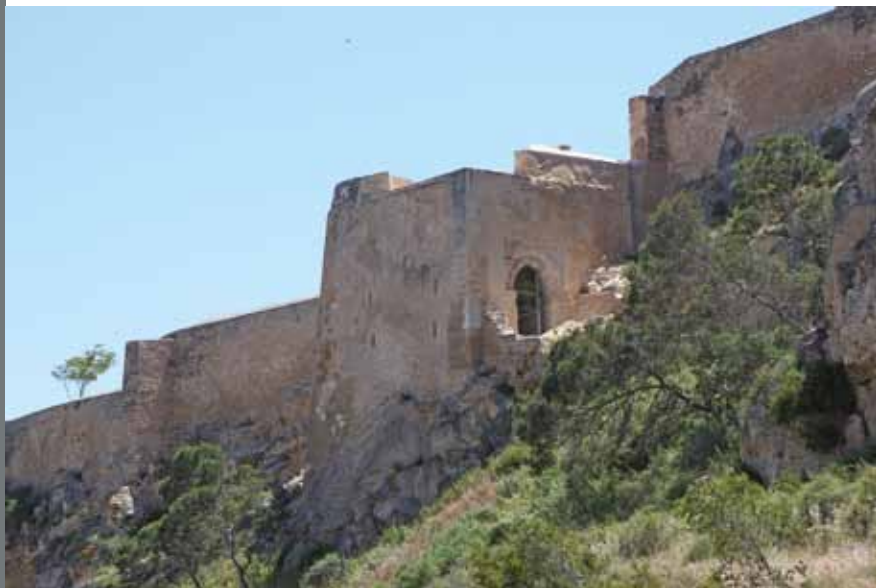
Figura 25. Vista Noroeste de la Torre de Sant Jordi, donde destaca la nueva apertura del arco.
