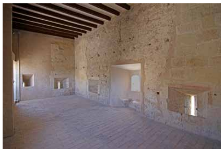
Figura 35. Vista interior del nivel superior de la Torre de Santa Caterina, donde se han conservado los tapias en mejor estado, y se han recuperado las aspilleras.
