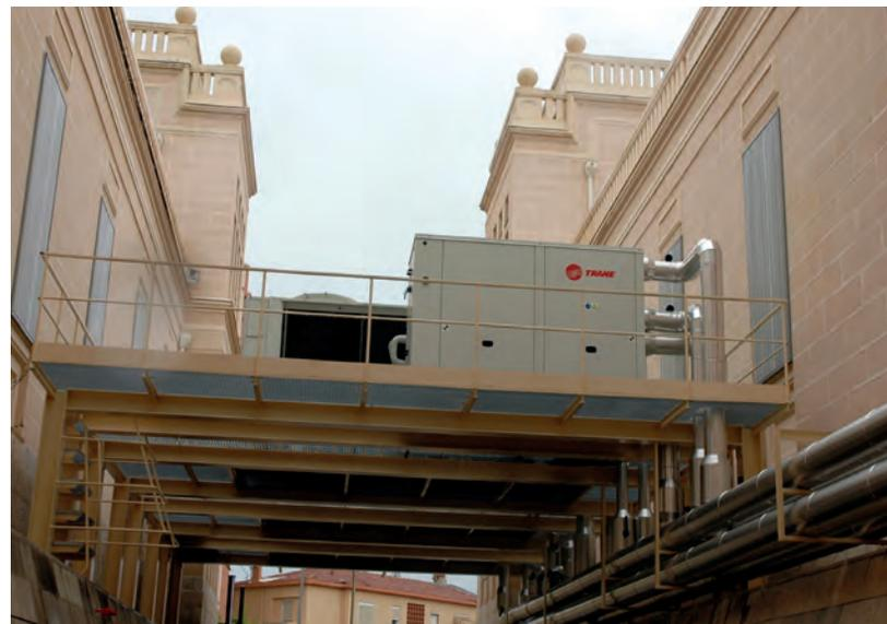
Figura 24. Maquinaria del sistema de climatización del MARQ.
